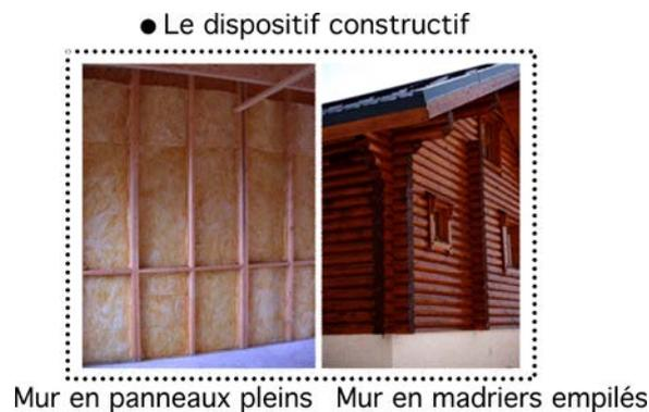
Figure 39 : Caractéristique graphique « le dispositif constructif ».
