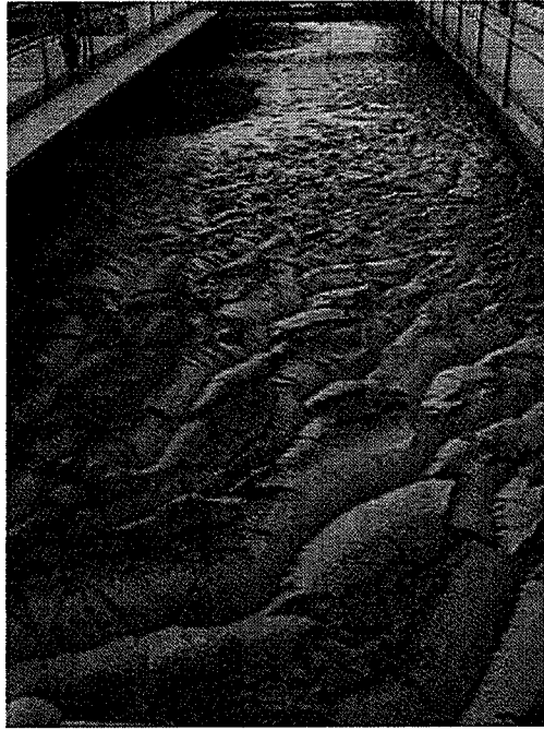
Figure 15 : Mousse engendrée par Microthrix parvicella dans un bassin d'aération.
