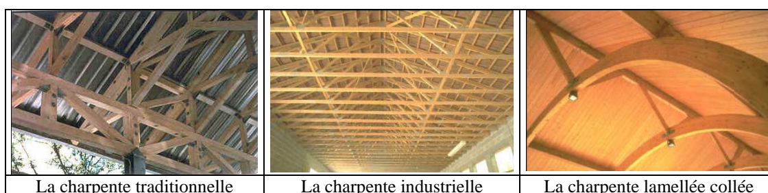
Figure 7– Les divers types des charpentes en bois
