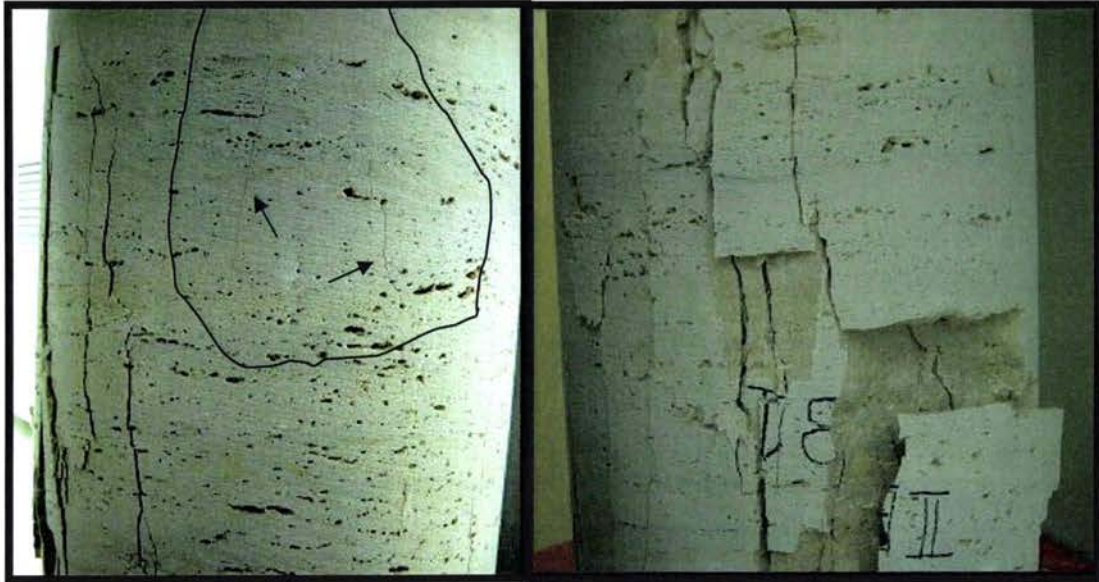
Figure 3.17 : Rupture en cône de l'échantillon II-B1 à gauche et au centre.
