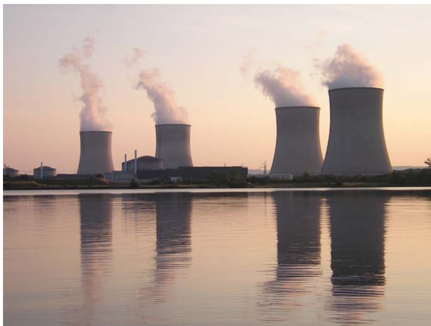
Figure 20 : Le réservoir du Mirgenbach, annexe hydraulique de la centrale électronucléaire de Cattenom.
