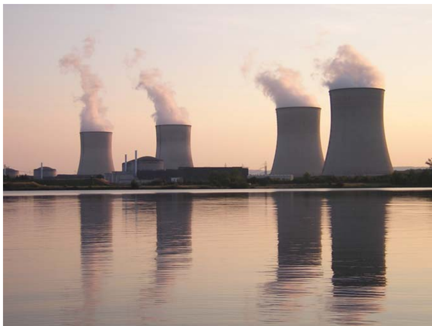
Figure 20 : Le réservoir du Mirgenbach, annexe hydraulique de la centrale électronucléaire de Cattenom.
