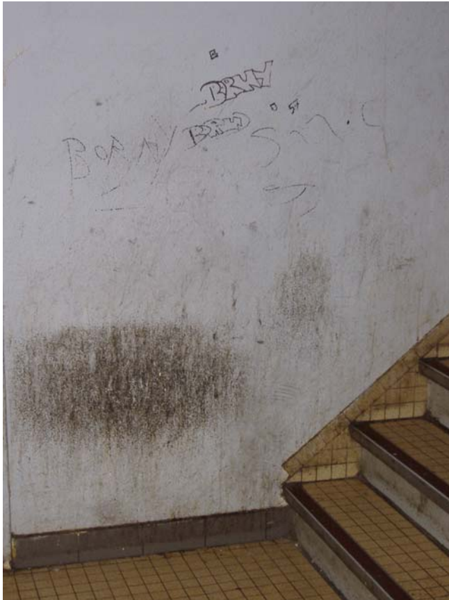
Vue de la première cage d'escalier d'un hall d'entrée situé dans la « Cour du Languedoc » du quartier de Metz Borny.
