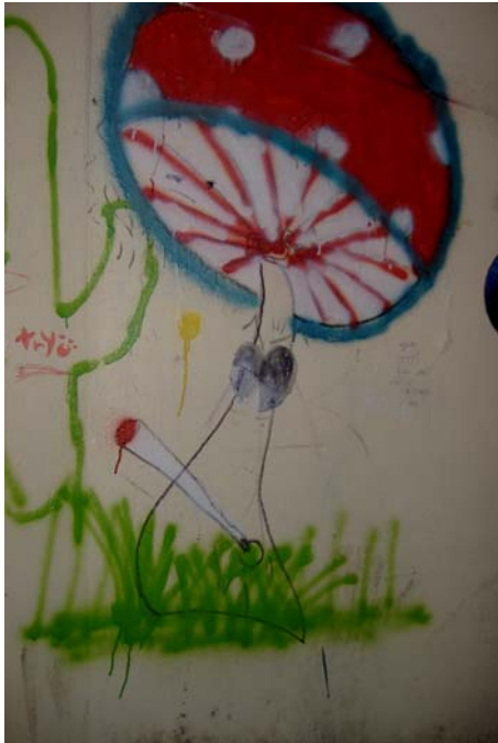
Vue de la paroi intérieure gauche de l'abribus de Bettelainville
