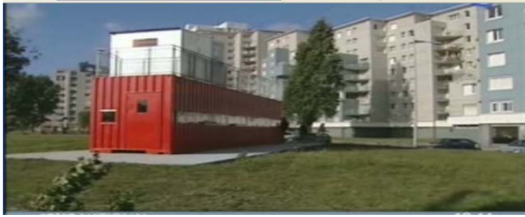
Vue extérieure de du « hall sans immeuble » de Graville - la - Vallée, quartier de la ville du Havre (vu à la télévision sur FR3, le 26.09.2007).
