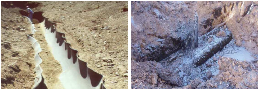
Figure 3 : Eclatement d'un pipeline (a) et (b) l'effet sur l'environnement [4].
