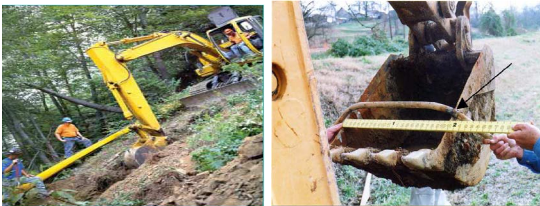
Figure 5 : Photo des agressions mécaniques extérieures.
