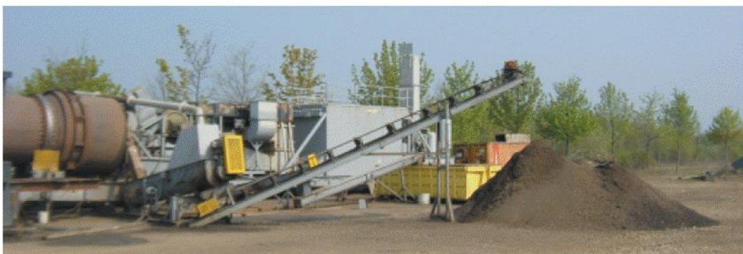
Figure 7 : Installation mobile de désorption thermique pour le traitement de sols contaminés (source DRIRE Lorraine, http://217.167.195.132/webdrire/files/DEI/Bilan02SSpollues.pdf ).
