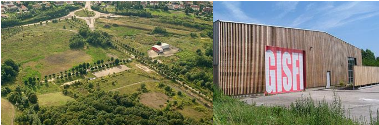
Figure 6 : Photographies du site de la cokerie d'Homécourt (54) avant son démantèlement (haut). La station expérimentale du Groupement d'Intérêt Scientifique sur les Friches Industrielles s'est installée sur le site de la cokerie après son démantèlement (bas) (source GISFI, http://www.gisfi.fr ).
