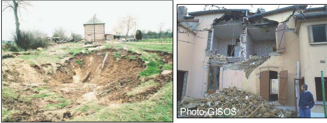
Figure 4.2 : Exemples de dégâts observés en surface dans le bassin ferrifère lorrain.
