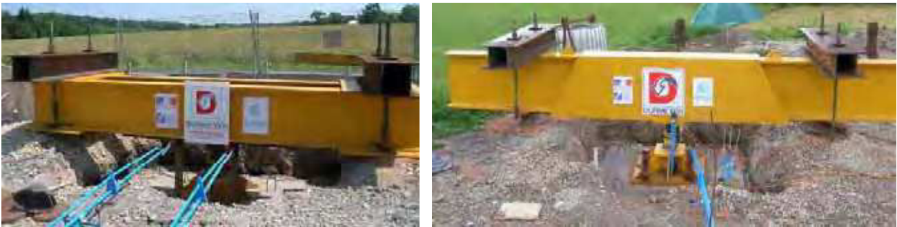
Figure II 28 - Essai de chargement de la semelle sur le sol naturel (gauche) et sur la colonne (droite).
