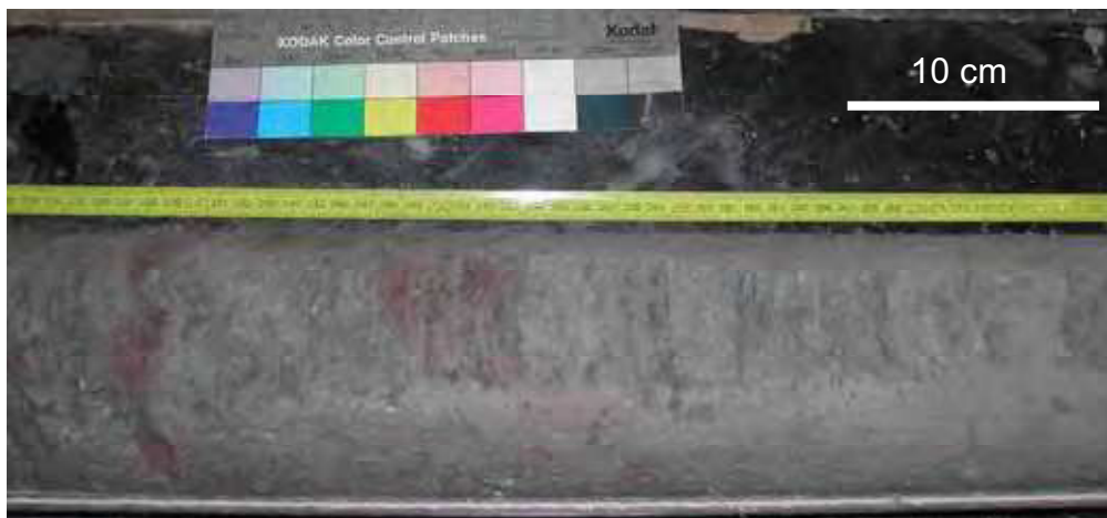
Figure 12 - Carotte de 6,43 à 6,88 m
