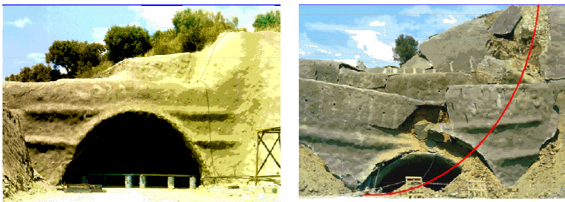
Figure 6. Tunnel de Patra avant et après l'effondrement (Grèce, août 1998), (Patra, 2004)
