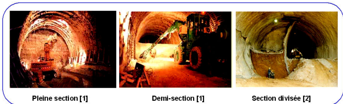
Figure 12. Différentes techniques du creusement [1], [2]
