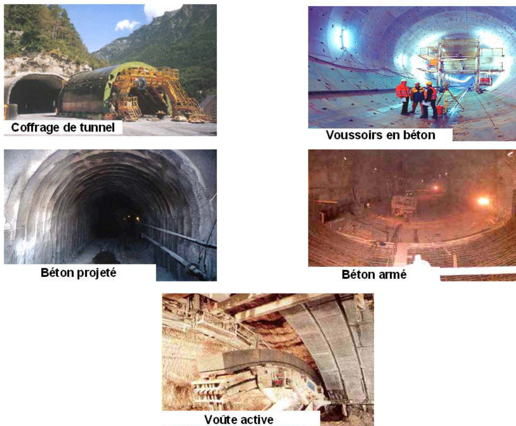
Figure 20. Différents types de soutènement, revêtement [10]
