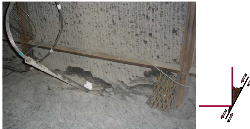
Figure 7.40 - Fracturation observée dans la galerie de Tournemire
