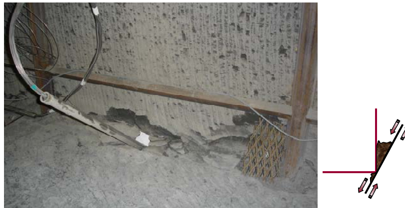
Figure 7.40 - Fracturation observée dans la galerie de Tournemire
