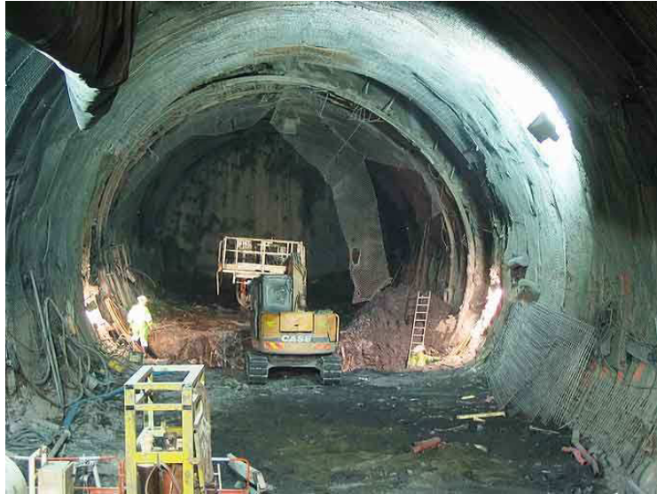
Figure 2.6 – Conséquences du phénomène de « squeezing » dans la descenderie de Saint Martin La Porte (www.ltf-sas.com)
