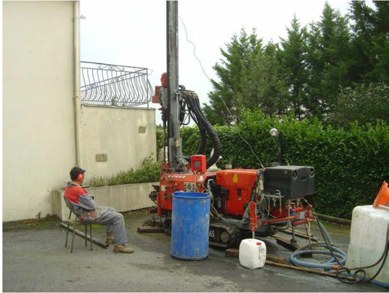
Figure 1.22. Réalisation d'un sondage destructif à proximité d'une habitation
