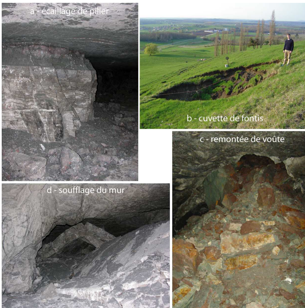
Figure 3.15. Différents désordres rencontrés dans la carrière
