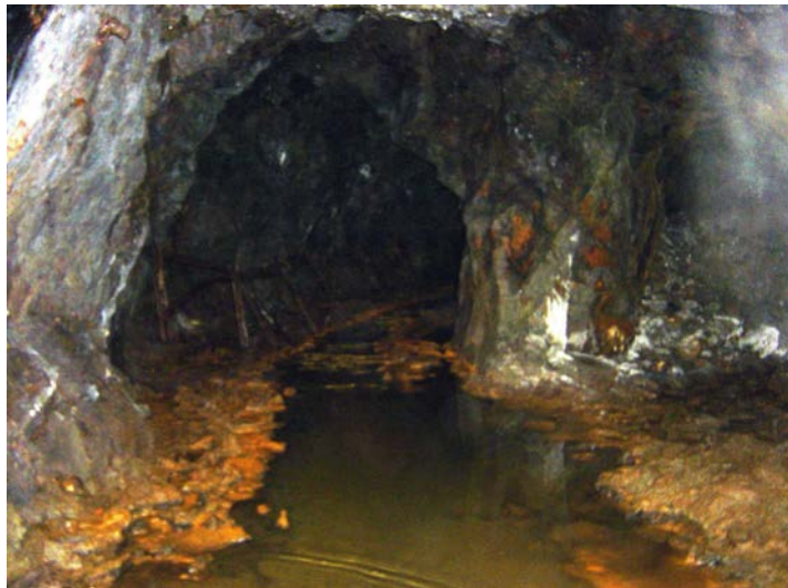
Figure 1.13. Vue d'une galerie exondée située au-dessus du niveau d'une nappe aquifère
