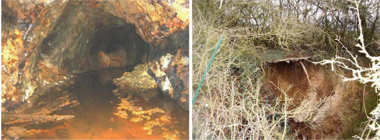
Figure 1.15. Blocs tombés en galerie (a), et Effondrement de la descenderie de la Boissière (13/07/2000) (b)
