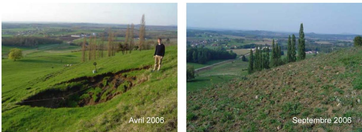
Figure 3.18. Comblement d'une cuvette de fontis entre avril et septembre 2006
