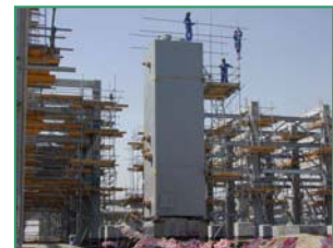
Figure I.4 - Montage sur site
