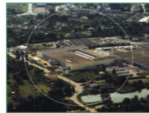
Figure I.3 - Site de NORDON Cryogénie
