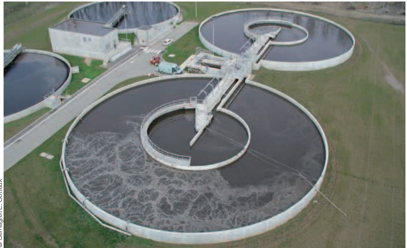
• Station d'épuration, installation de traitement à boues activées.
