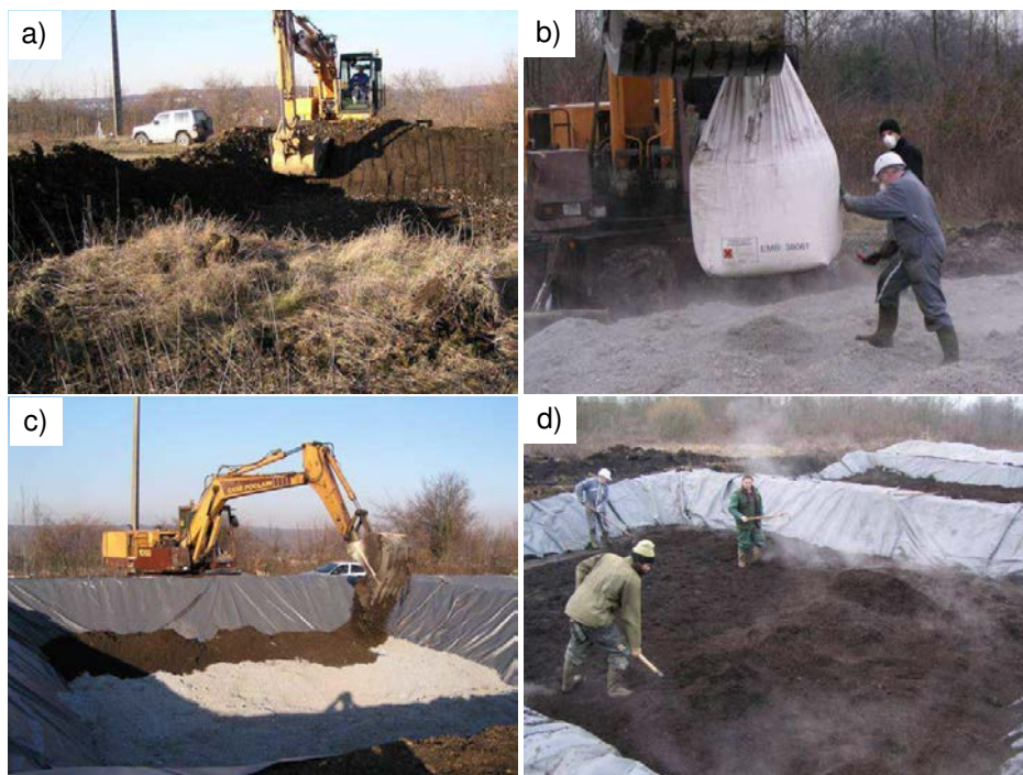
Figure 9 : Mise en place du dispositif pilote de construction de sol en parcelles lysimétriques a) terrassement des bassins ; b) mélange des matériaux parents ; c) et d) mise en place des couches
