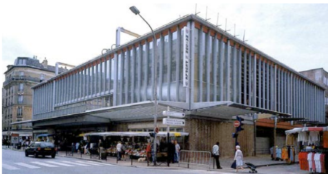
Photo N° 3 (annexe 16) : Maison du peuple à Clichy. Façade de la galerie marchande avec marquise. Etat en 1998, pendant la restauration. Marcel Lods, architecte. (Sulzer, 2000)
