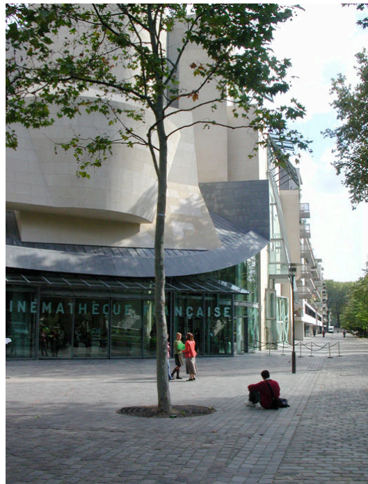
Fig.4 (annexe17). Centre américain à Paris. Gehry, architecte. (photo :N.Hoyet)
