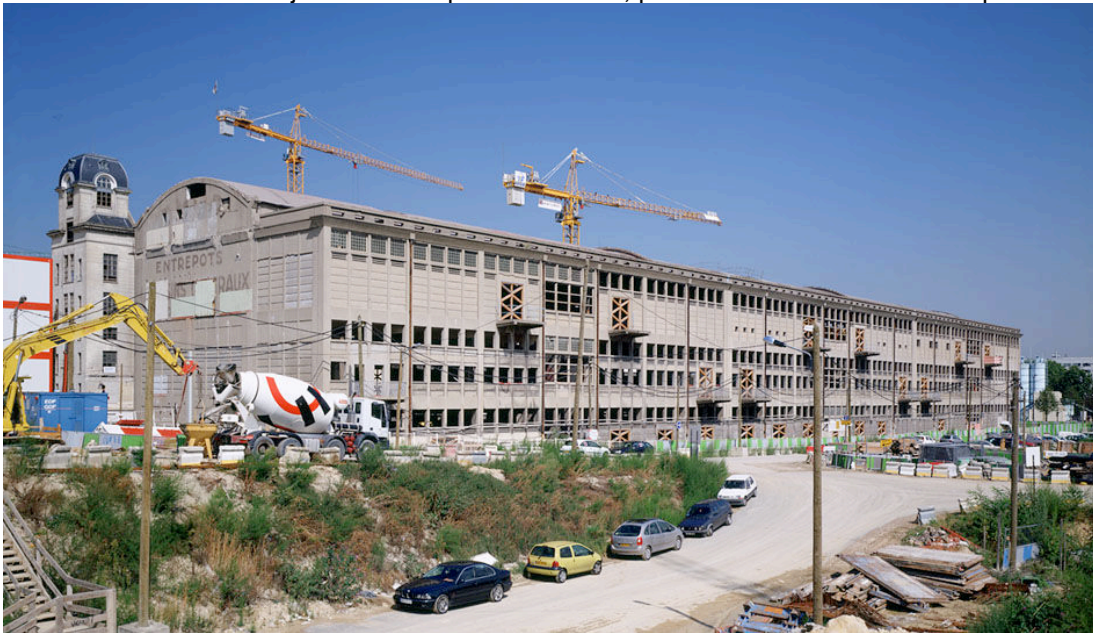
Rénovation de la Halle aux farines.
