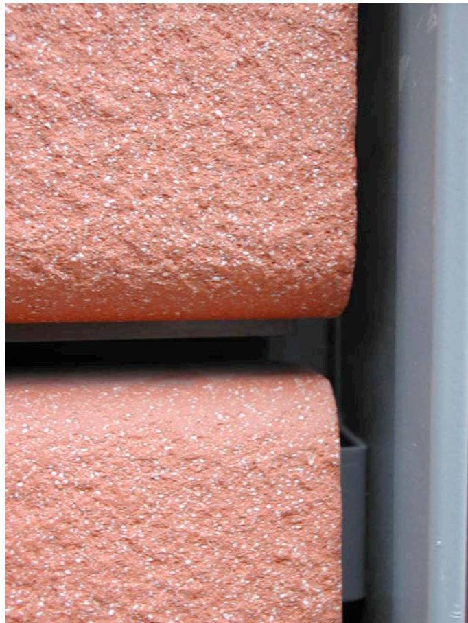
Vue rapprochée du prototype de bardage en terre cuite.
