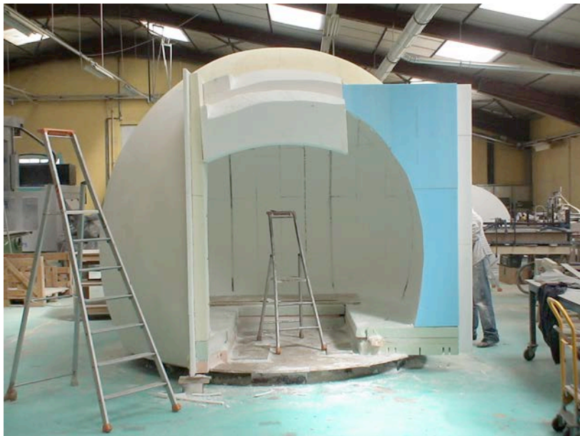
Photo N° 19 : Réalisation du moule d'une des « cabanes » de la crèche Jean Jaurès. Luc Boulais, conseillé pour la mise en œuvre des matériaux composites. (document fourni par l'architecte).
