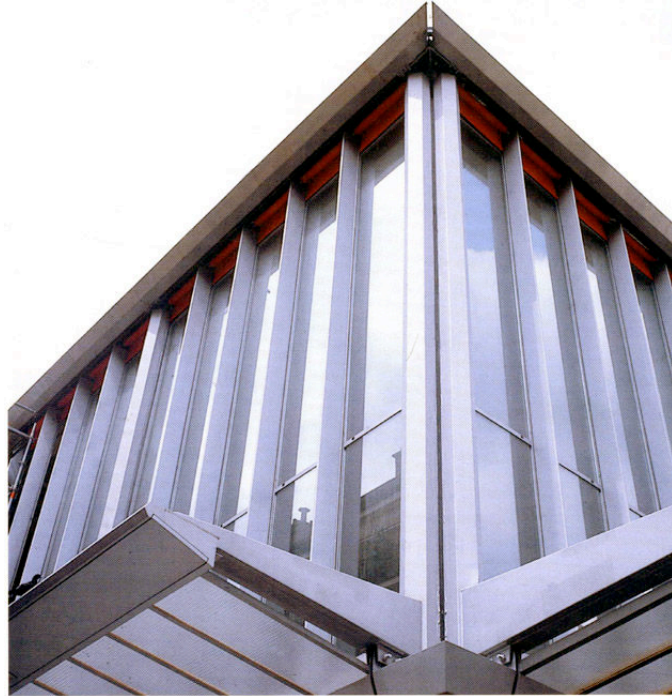
Photo N° 2 (annexe 16) : Maison du peuple à Clichy. Façade de la galerie marchande avec marquise. Etat en 1998, après restauration. Marcel Lods, architecte. (Sulzer, 2000)
