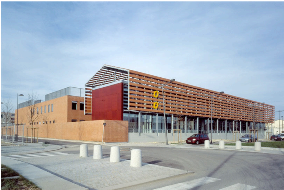
Laboratoires à Oullins. Jacques Ferrier, architecte. Document transmis par l'architecte
