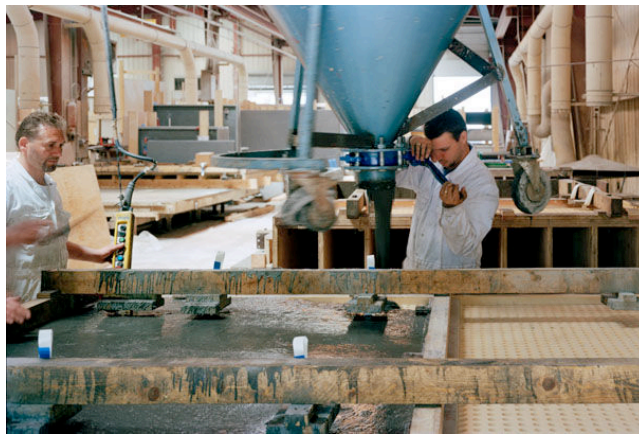
Photo N°16 : Coulage du Ductal® dans les ateliers du pré-fabricant Betsinor (document fourni par Lafarge)
