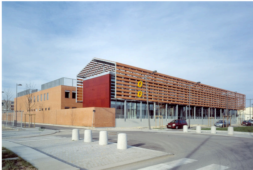
Photo N°2 : Laboratoires à Oullins (69) ; Jacques Ferrier , architecte. [document fourni par l'architecte]
