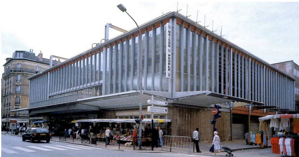
Photo N° 26 : Maison du peuple à Clichy. 1935-1939 . Etat en 1998 pendant la restauration. Fabrication du mur rideau par les Ateliers Jean Prouvé. Architecte : Marcel Lods. (in Sulzer, 2000)
