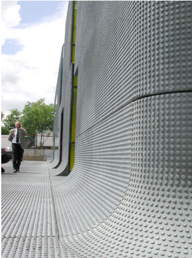
Photo N°7 : Bureaux pour la RATP à Thiais (banlieue parisienne). Détail de l'enveloppe en pied de mur : continuité entre sol et façade. Emmanuel Combarel et Dominique Marrec, architectes. [photo N. Hoyet]
