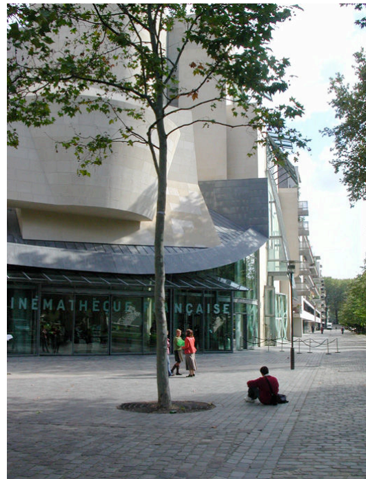
Fig.4 (annexe17). Centre américain à Paris. Ghery, architecte. (photo :N.Hoyet)
