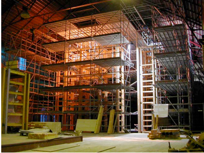
Vue du chantier du musée du cristal St Louis « incontestablement en bois » . Lipsky-Rollet, architectes. Document fourni par l'architecte
