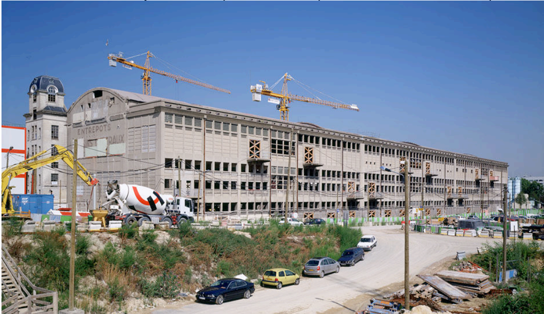
Rénovation de la Halle aux farines.
