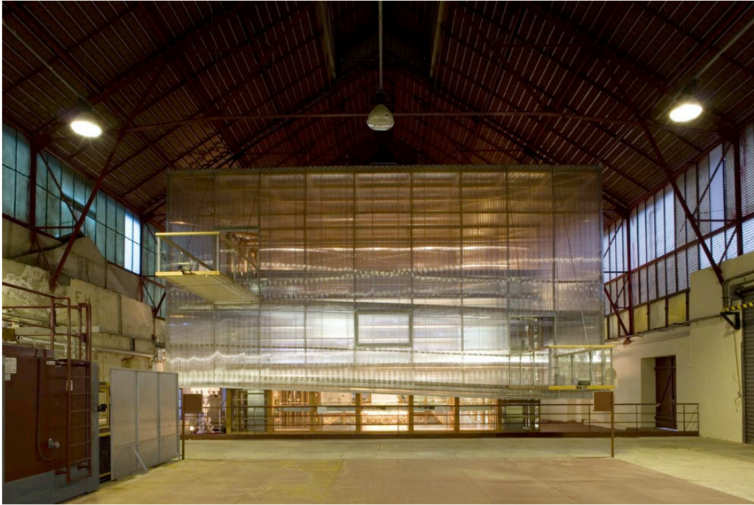
Façade intérieure du musée du cristal St Louis en polycarbonate . Lipsky-Rollet, architectes. Document fourni par l'architecte
