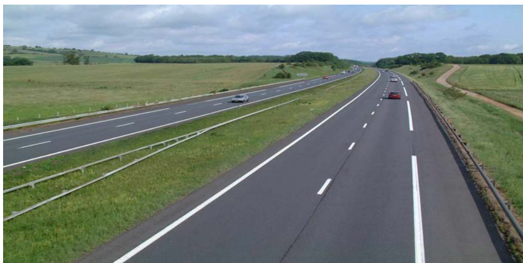
Photo 2 : Site autoroutier A31
