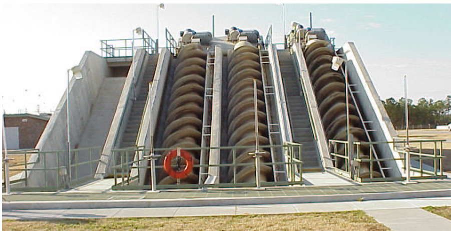
FIG. A.3 – Vis sans fin pour relever le niveau de l'eau
