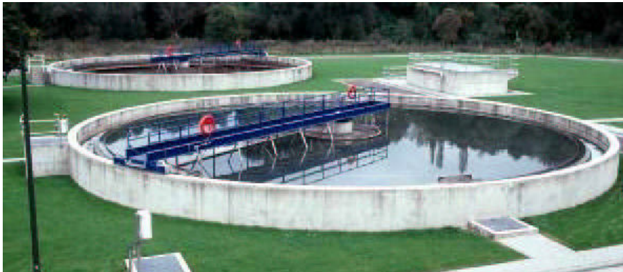
FIG. A.9 – Décanteur secondaire ou clarificateur
