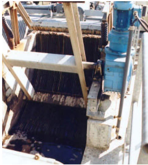
FIG. A.4 – Grille du degrillage fin
