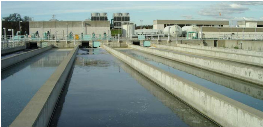
FIG. A.7 – Décanteur primaire
