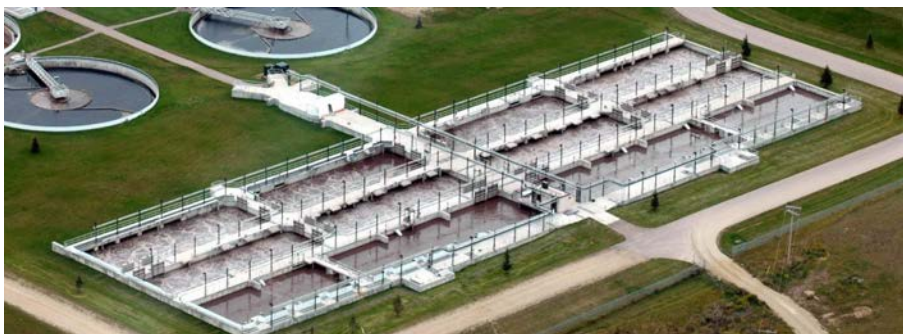
FIG. A.8 – Bassin d'aération : 1/3 anoxie et 2/3 aérobie
