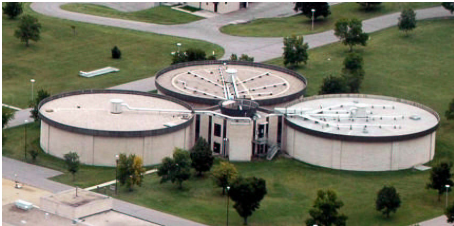
FIG. A.10 – Unité de digestion des boues
