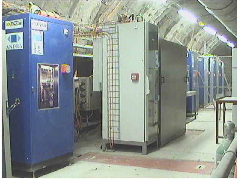
Figure 4.9 : Vue de la galerie multi-expérimentale à - 490 m.
