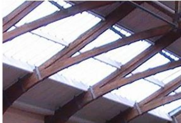
Figure I-4 : Charpente de la gare de Dieppe
