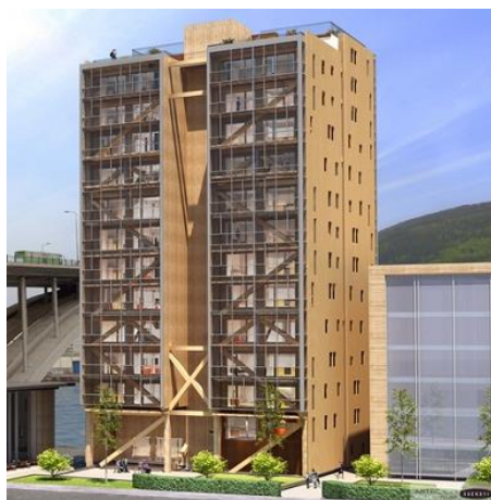
Figure I-2 : Immeuble de grande hauteur en bois de 14 niveaux en Norvège [4]
