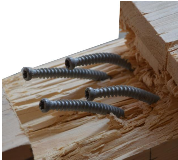
Figure III-110 : Flambement des vis sous appuis
