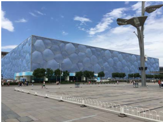
(a) Façades en matériau plastique ETFE
