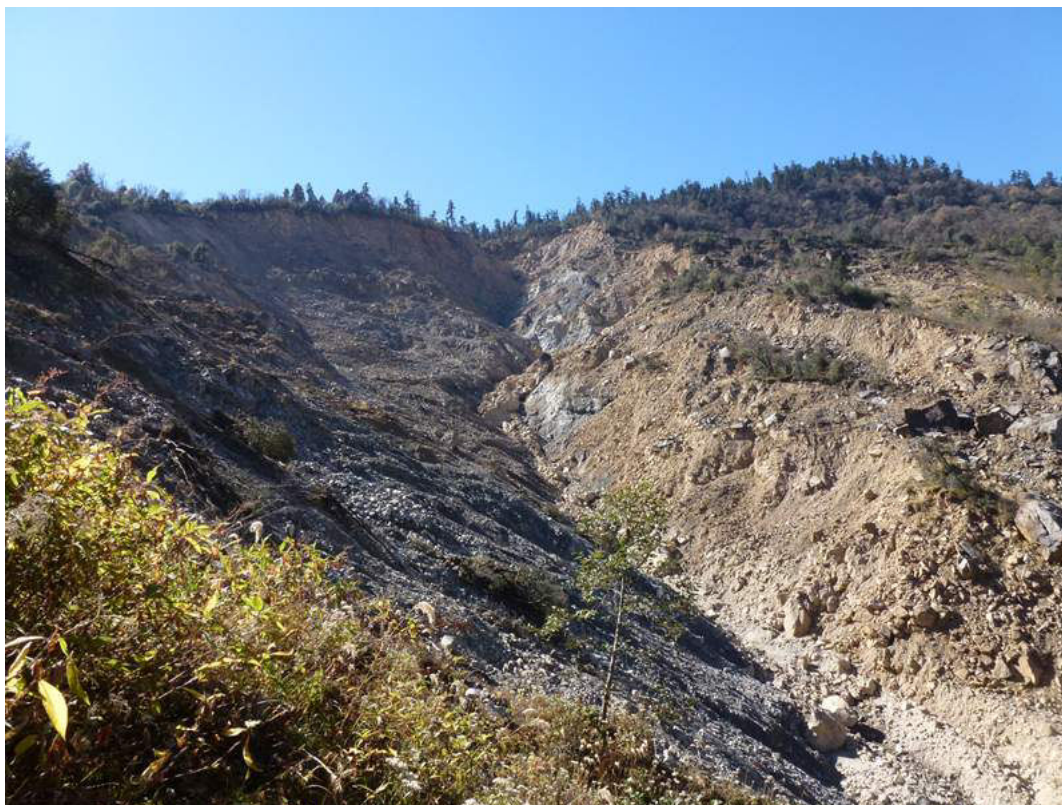
FIGURE 2.2.2 – Vue en contre-plongée du glissement de terrain de Saituti en Novembre 2012.
