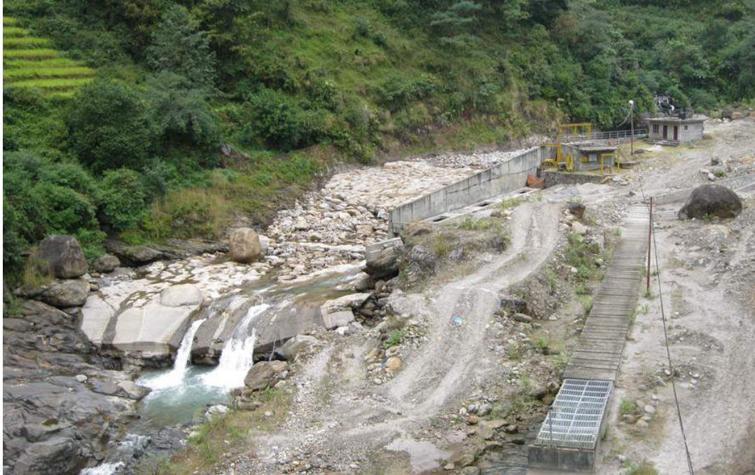
FIGURE 2.2.3 – Station de captage d'eau de la station hydroélectrique située à 4,5 km en amont de la confluence avec la Marsyandi.
