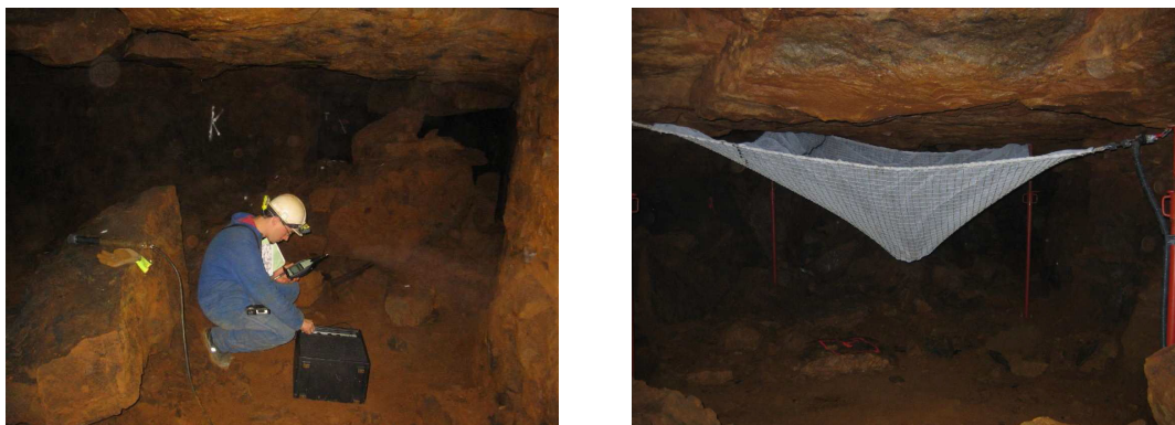
Figure 22 Solutions mises en place pour la surveillance des chutes de blocs à Moyeuve-Grande (INERIS, 2013)
