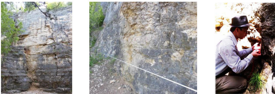
Fig.1. 48 Photo et géométrie de la zone d'intérêt du site de Maron.
