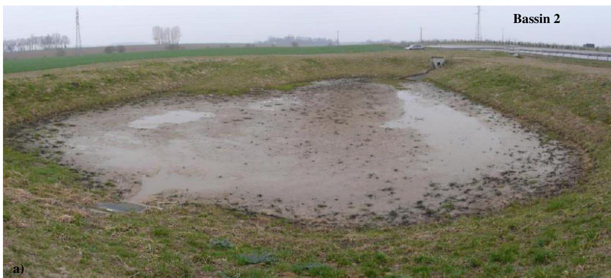
Figure IV.39 : État du bassin de rétention n°2 avant les travaux de réparation.
