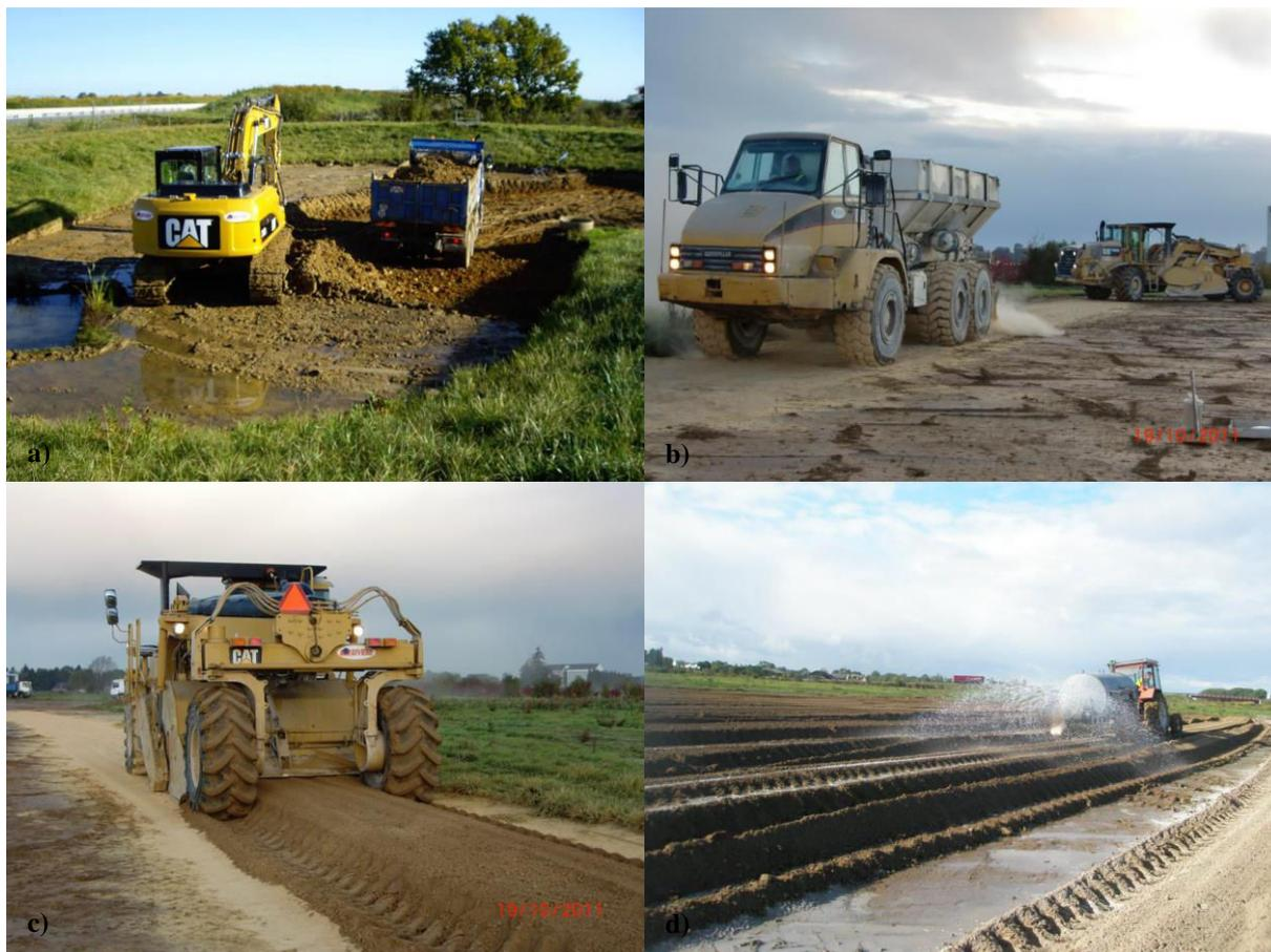
*Les différentes phases des opérations de préparation du terrain et du traitement du limon.*
