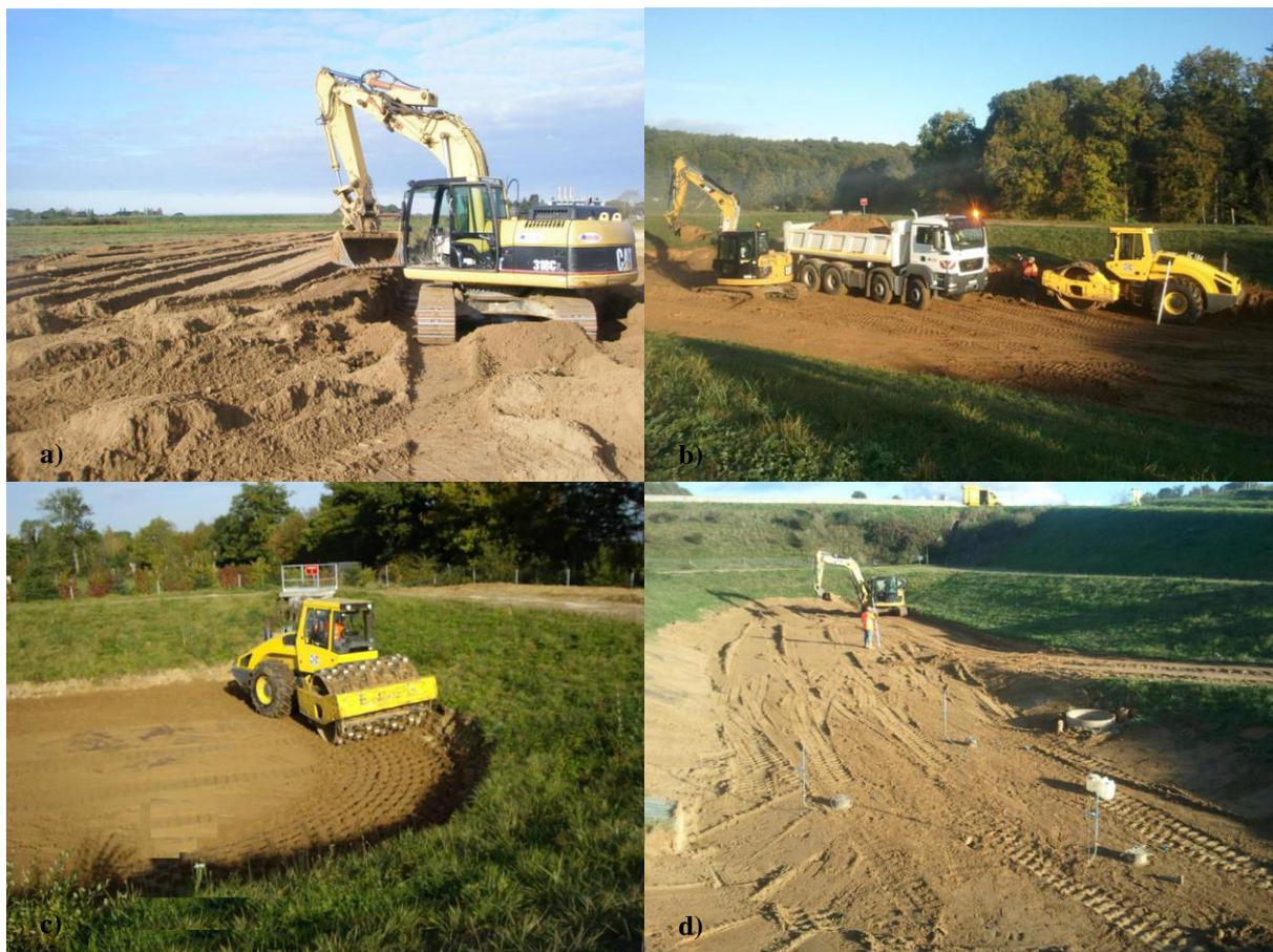
*Différentes opérations de mise en place et du compactage des couches de bassins.*
