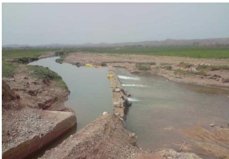
**Photo 8.2 : Endiguement de l'Oued et prise d'eau par canaux traditionnels.**
