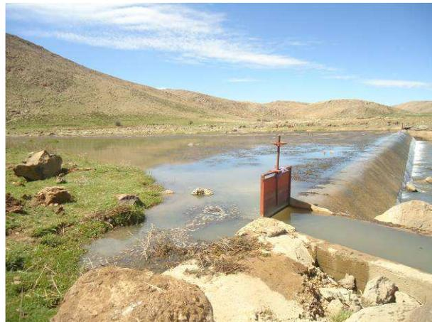
D'après l'enquête menée sur le terrain le finage Guigou-Timahdite possède plus de 30 prises d'eau (barrages). Elles sont pour la plupart de construction traditionnelle avec des blocs de basaltes ou d'autres matériaux locaux. Ces barrages archaïques sont souvent détruits par les crues. Les barrages modernes sont peu nombreux.
