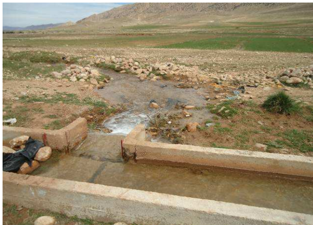
Photo 9.3 : Seguia en béton et en terre.
