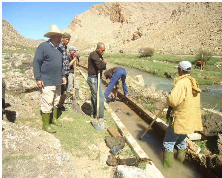
Photo 9.5: Le curage de la Séguia après le passage d'une crue.
