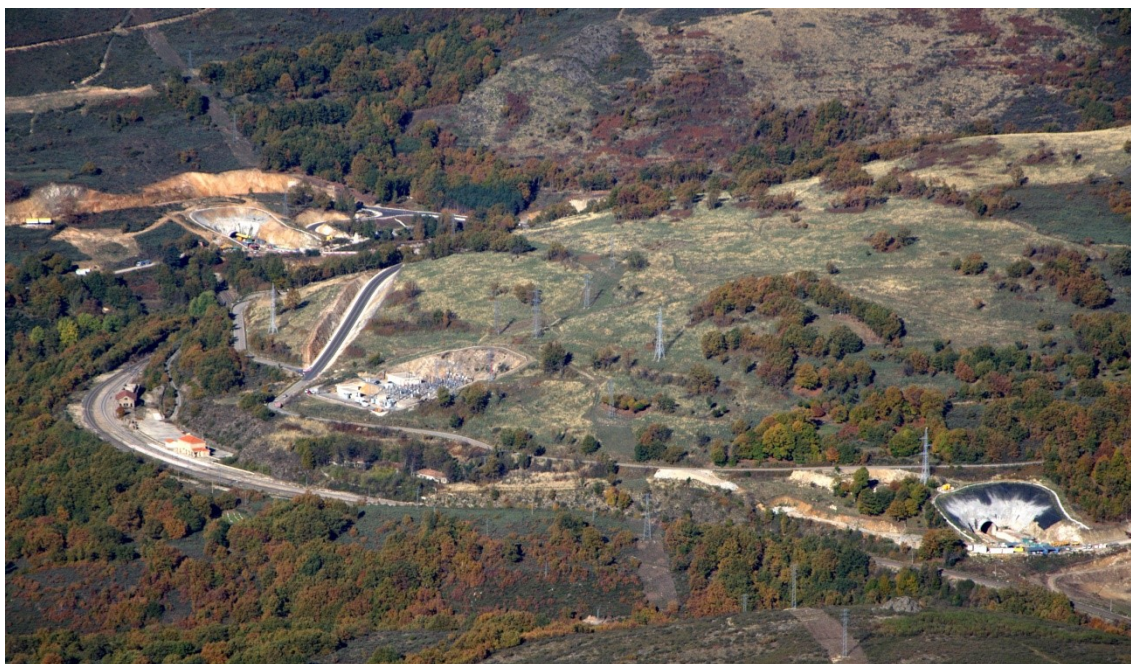
Figura 83. En el centro la Subestación eléctrica Lubián, constreñida entre la línea de ferrocarril convencional y la antigua carretera Villacastín-Vigo al sur y la línea eléctrica de 220 kV y los túneles de la línea de alta velocidad al Norte. D. Herrero, 2013.
