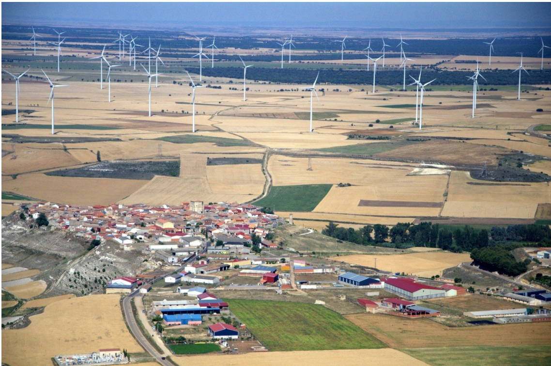
Figura 128. Panorámica de los aerogeneradores instalados entre Peñaflor de Hornija -primer plano- y el Monte San Lorenzo. D. Herrero, 2015.
