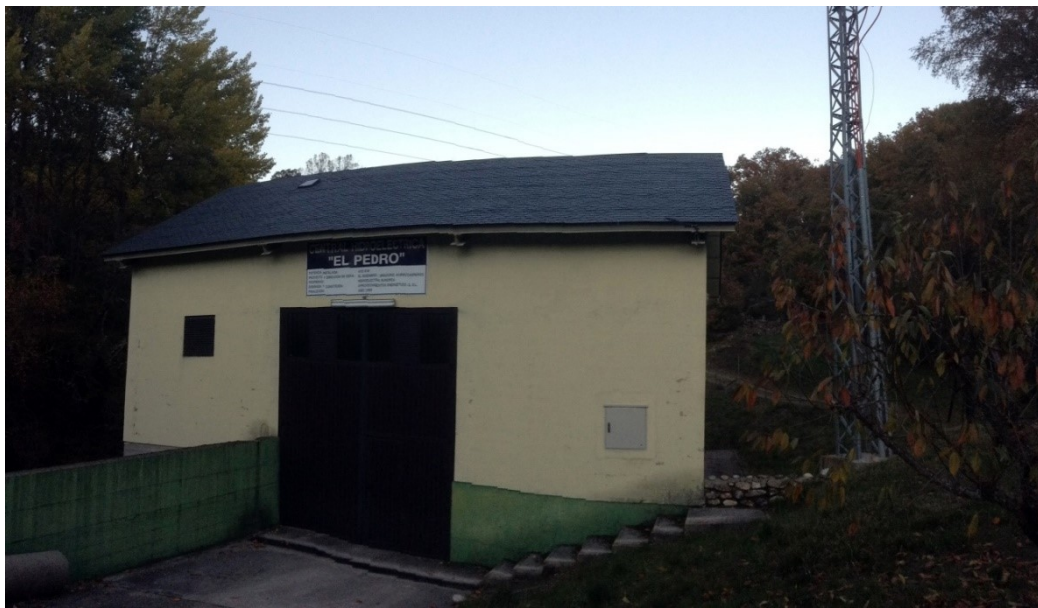
Figura 80. Central Hidroeléctrica El Pedro sobre el cauce del río Pedro en Lubián. D. Herrero, 2014.
