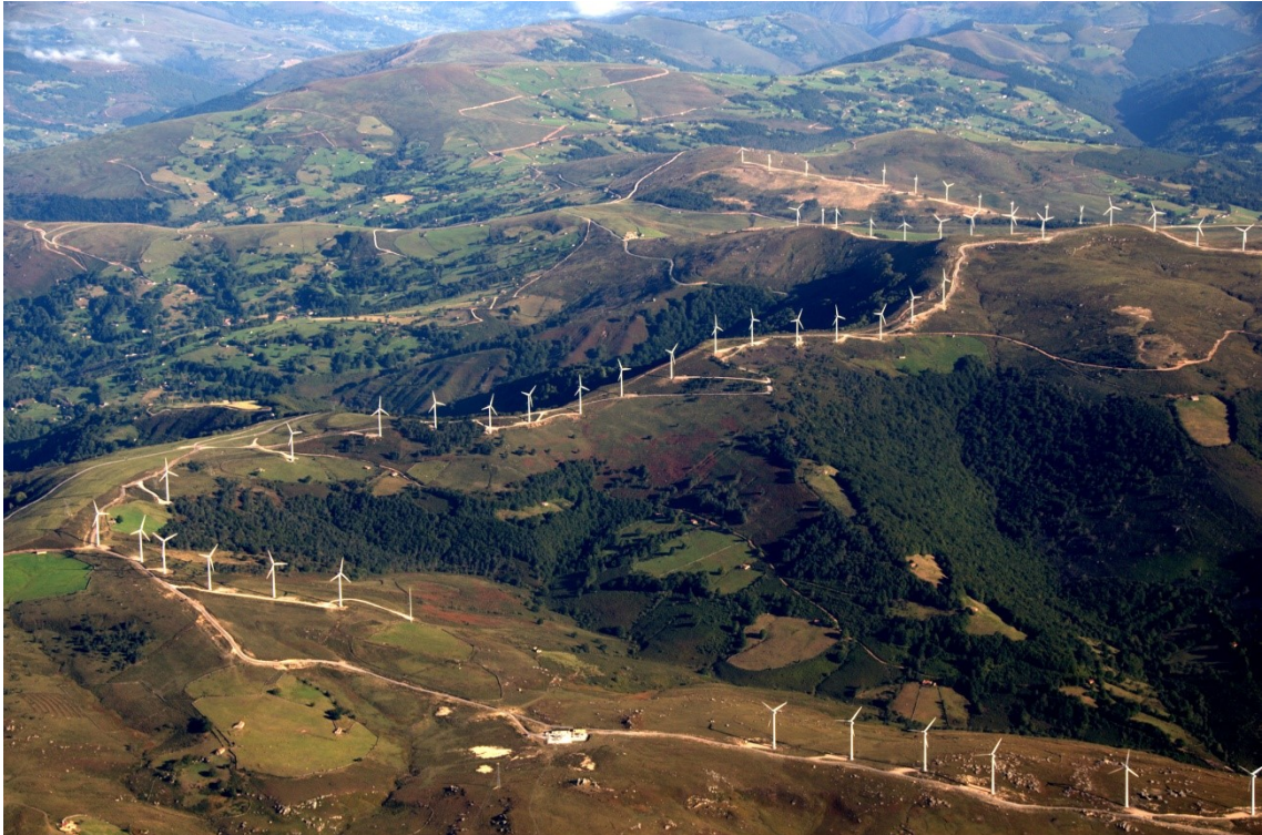
Figura 211. Parques eólicos instalados en Burgos, dispuestos en alineaciones sobre las cumbres de la divisoria con Cantabria. E. Baraja, 2011.
