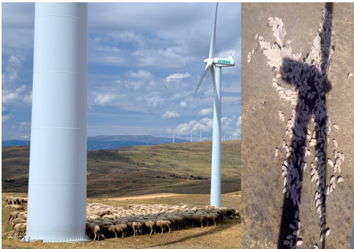
Figura 232. Rebaños de ovejas en la sombra de diferentes aerogeneradores en la provincia de Soria. D. Herrero, 2011 y Gabriel Mateo, 2015.
