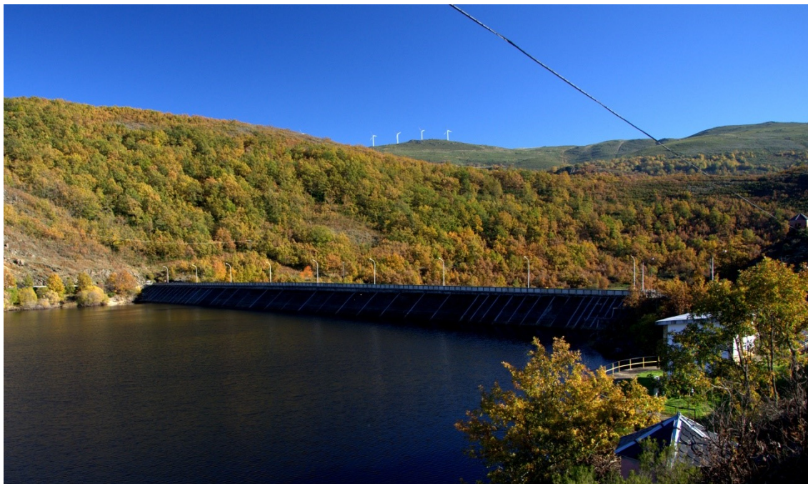
Figura 64. Presa y embalse de Pías en primer plano desde la margen derecha –Galicia-. Al fondo el parque eólico Sistral. D. Herrero, 2013.
