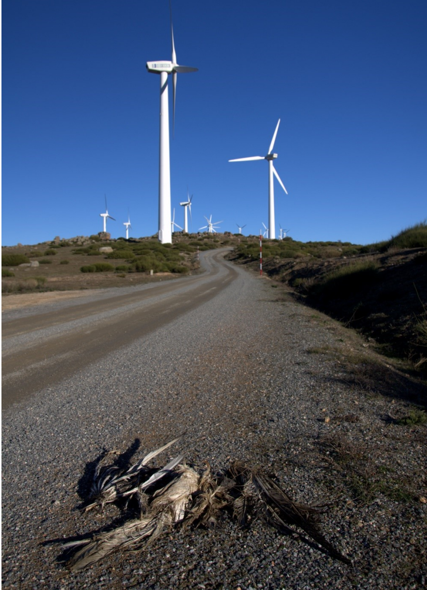
Figura 216. Ave fallecida por la colisión contra un aerogenerador en las inmediaciones del Puerto de la Lancha –Ávila-. D. Herrero, 2015.
