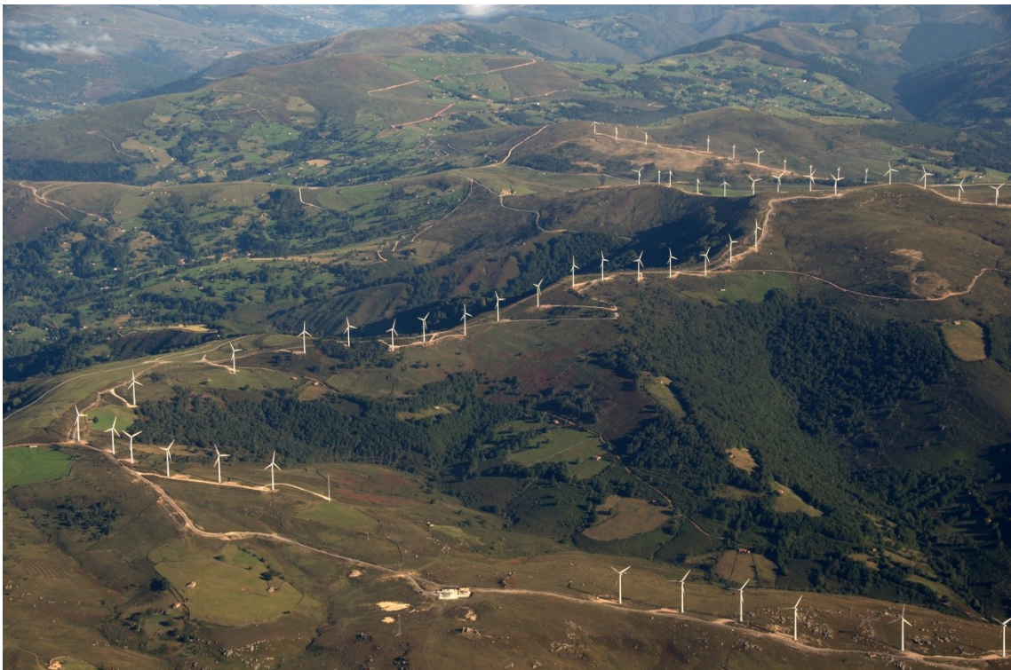
Figura 172. Parque eólico La Magdalena y subestación eléctrica homónima en primer plano. En el fondo los aerogeneradores del parque eólico Valdeporres, también promovidos por Iberdrola Distribución S.A. E. Baraja, 2011.
