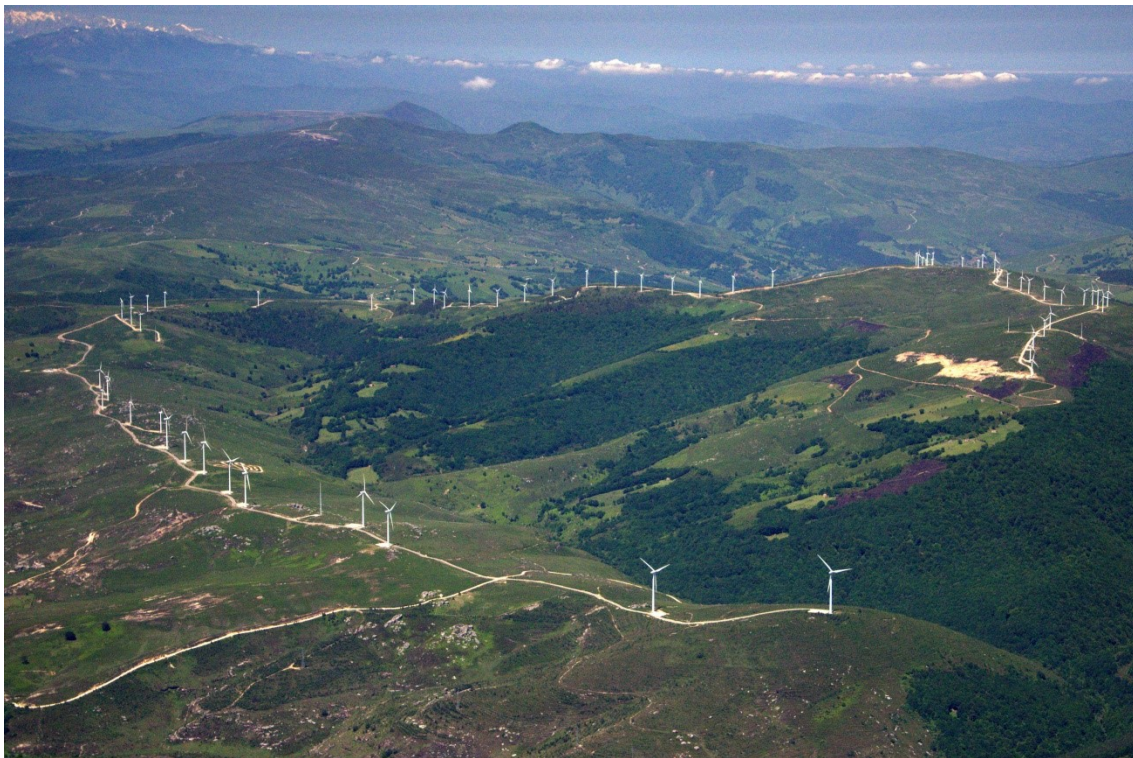
Figura 174. En primer plano los nueve aerogeneradores de 2 MW de potencia eólica instalada en el parque La Cotera, y a continuación el parque eólico La Magdalena.
