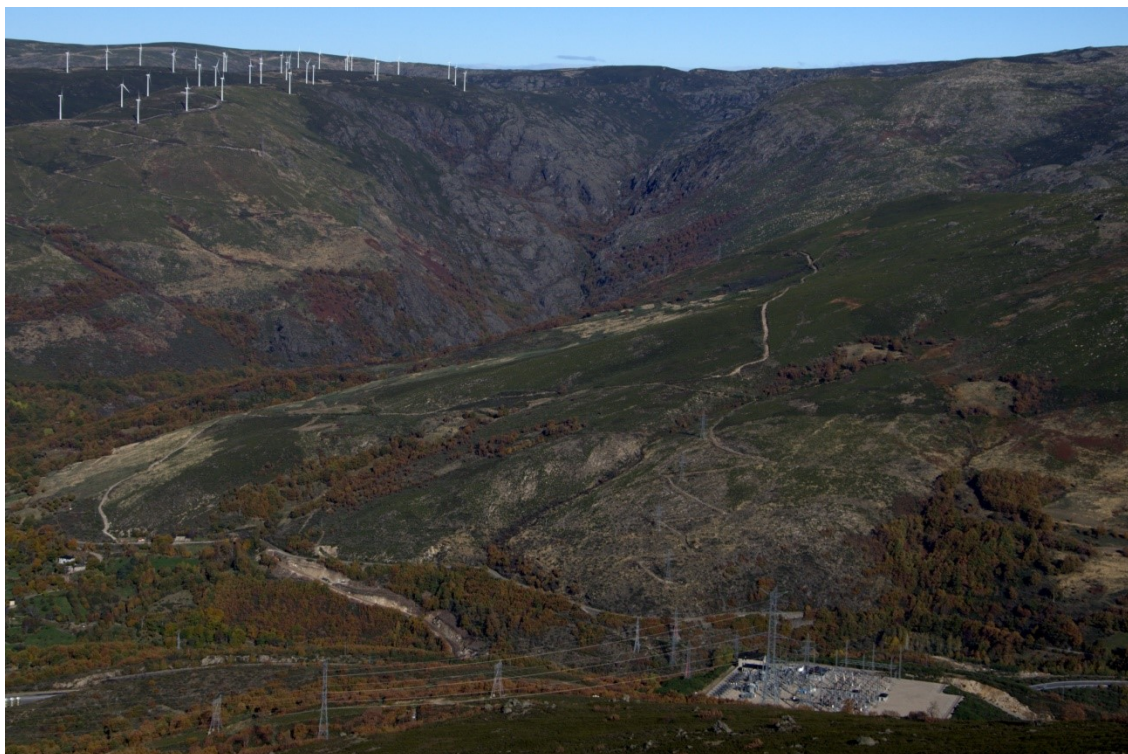
Figura 84. Subestación Aparecida, conectada a la línea de 400 kV Trives-Tordesillas, donde se ubica la subestación elevadora de Ibereólica 45/400. D. Herrero, 2014.
