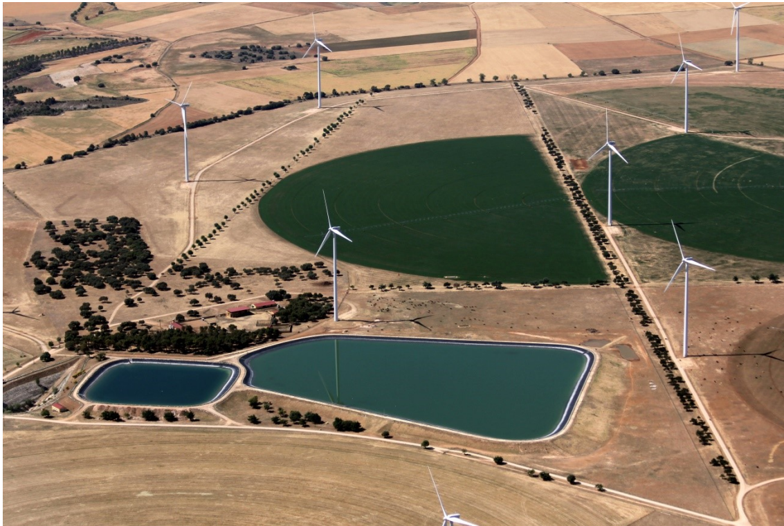
Figura 116. Balsas de agua extraída por bombeo para el sistema de regadío por aspersión de la finca Monte San Lorenzo, propiedad de Agropecuaria Monte San Lorenzo S.L. Ricardo Melgar, 2012.
