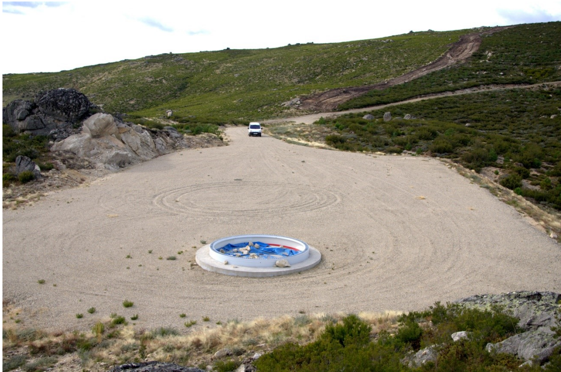
Figura 87. Base de uno de los aerogeneradores del proyecto paralizado de ampliación del parque eólico Nerea. D. Herrero, 2013.
