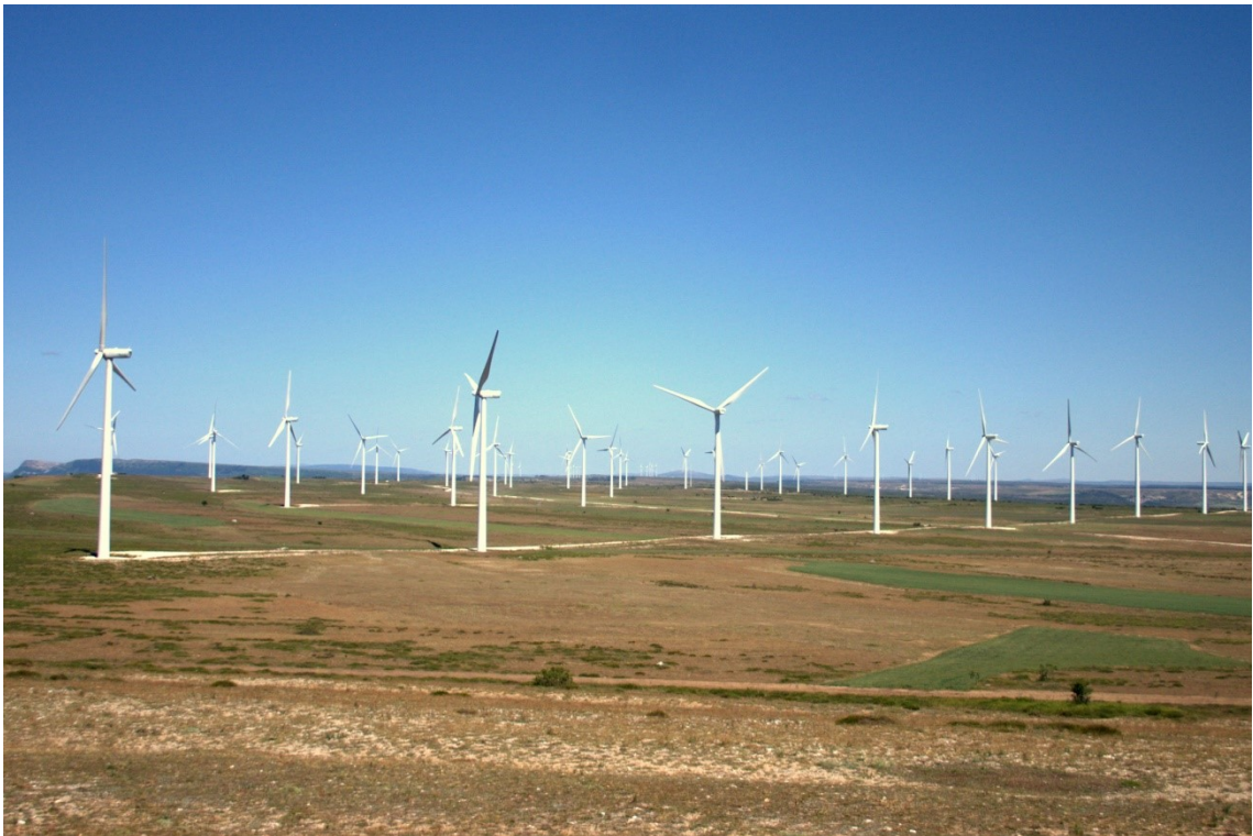
Figura 178. Disposición matricial de los parques eólicos La Lora I y La Lora II. D. Herrero, 2011.
