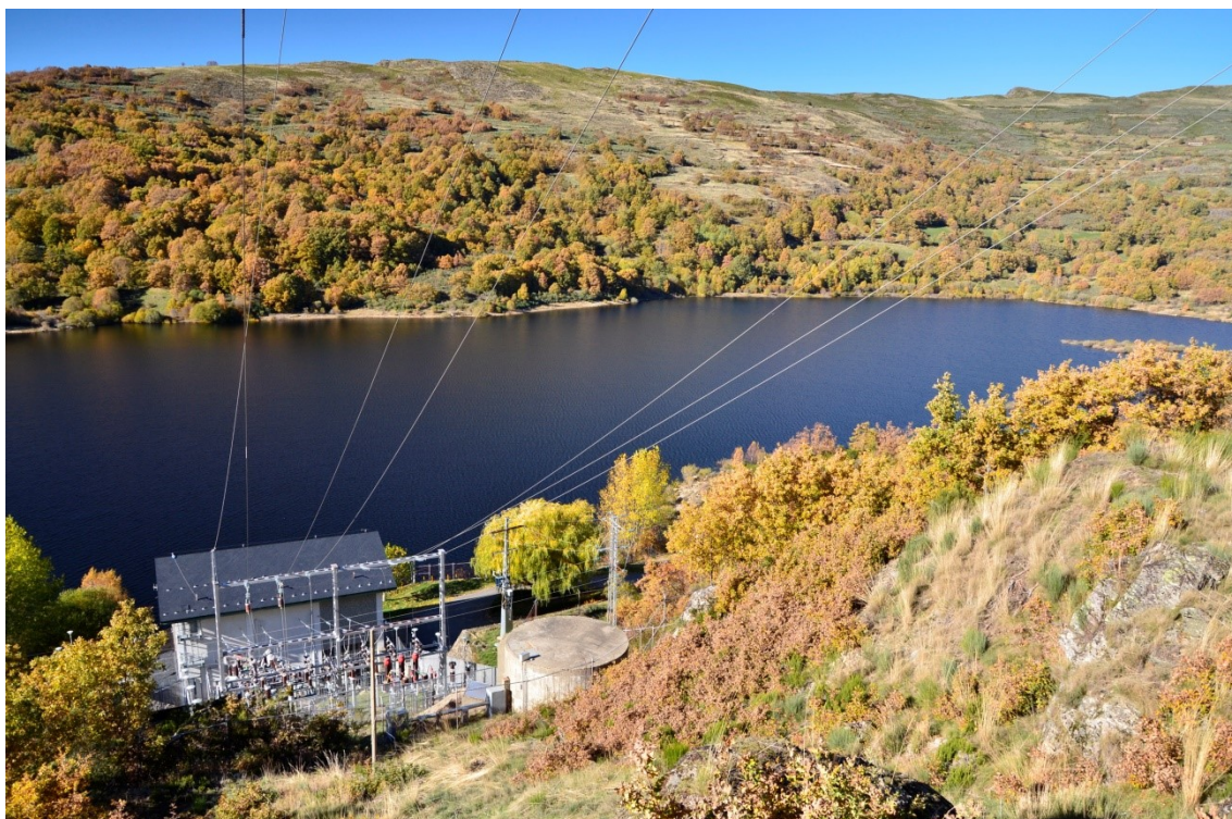
Figura 63. Central eléctrica de Porto en la margen izquierda del embalse de San Sebastián. D. Herrero, 2013.
