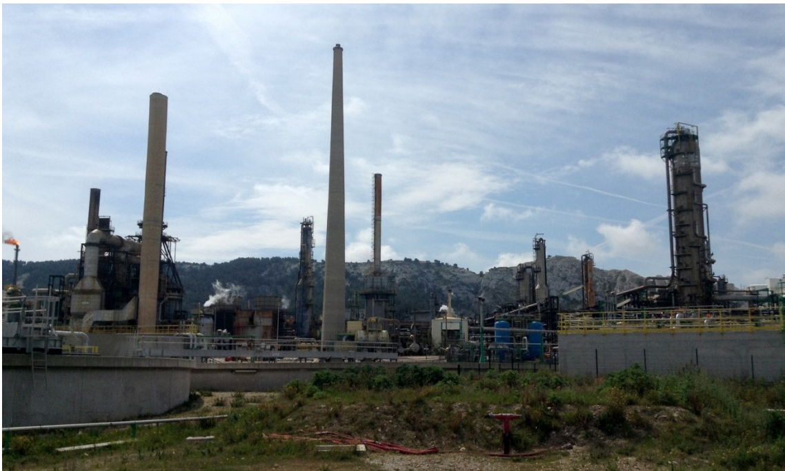
Figura 13. Refinería Province en Châteauneuf-les-Martigues, a 25 kilómetros de Marsella. D. Herrero, 2014
