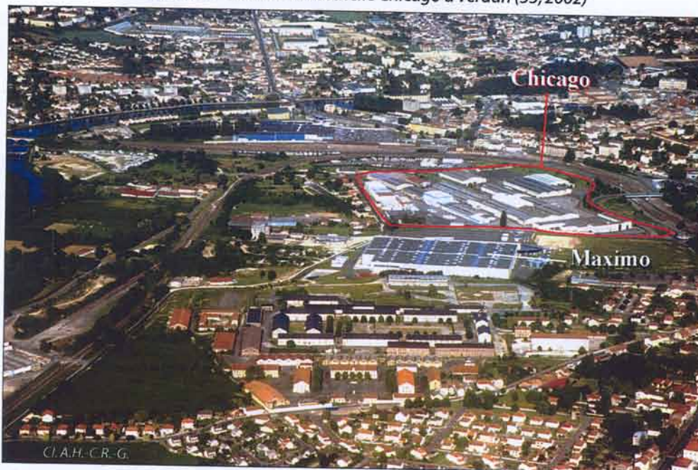
Photo 95 - La zone industrielle Chicago à Verdun (55, 2002)
