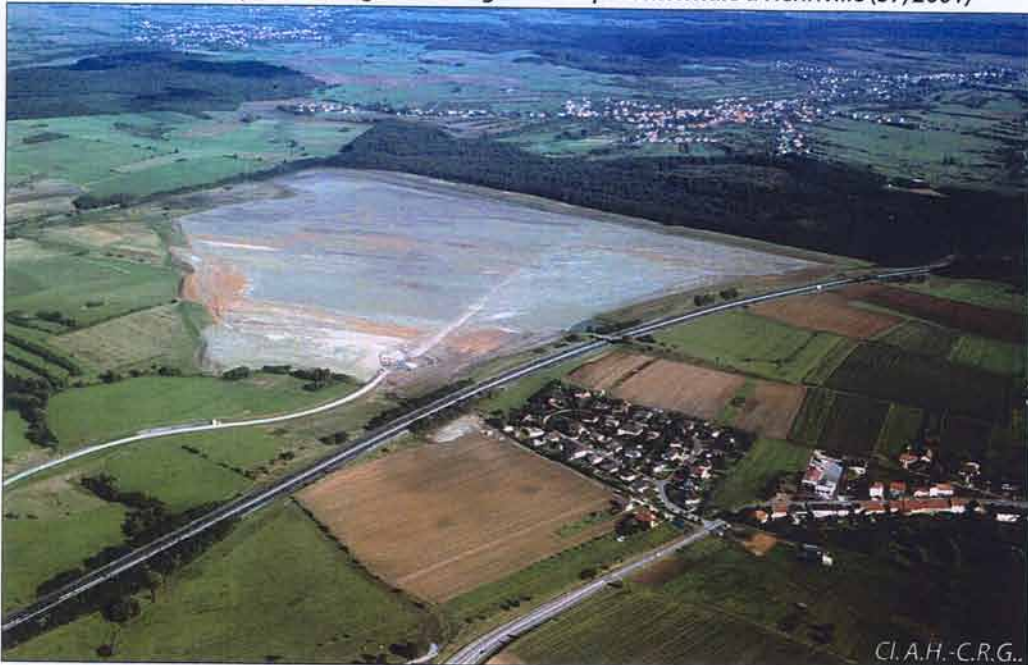
Photo 84 - Le plateformage de la mégazone départementale d'Henriville (57, 2001)
