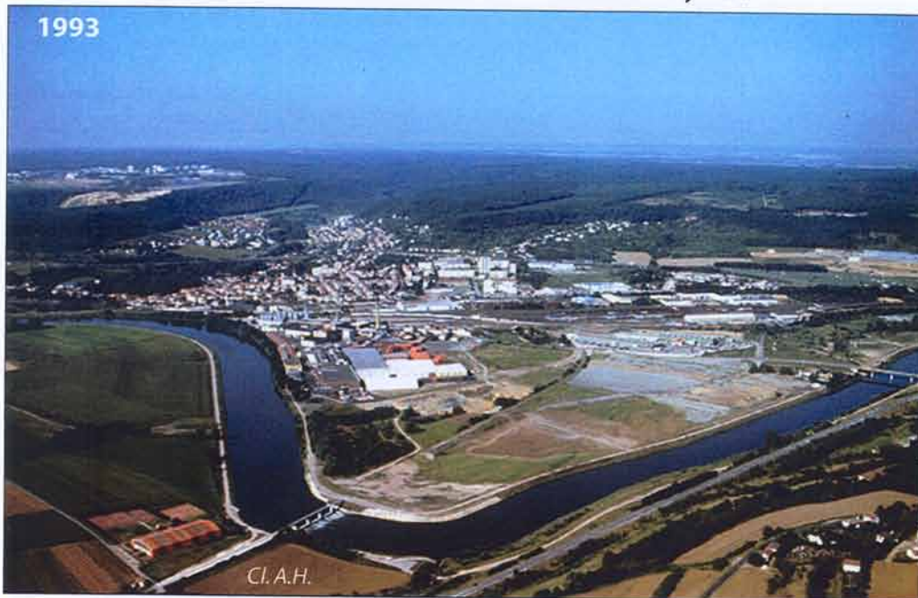
Photo 82 et 83 - Plate-forme multimodale de Nancy-Nord
