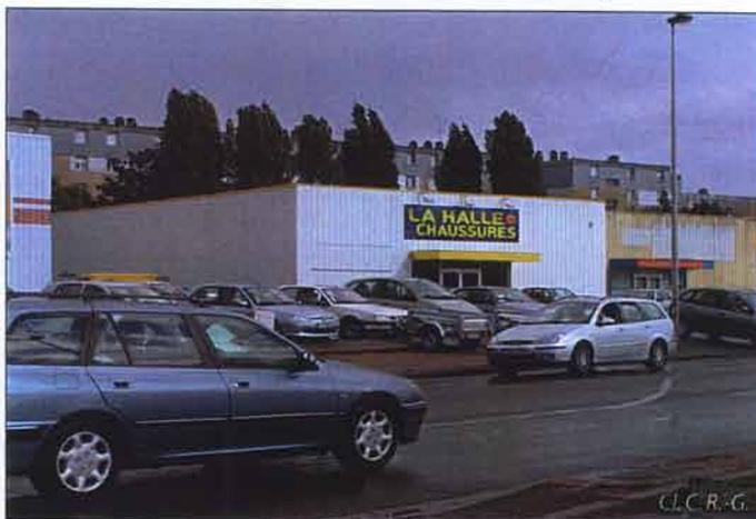
On remarquera également la différence d’habillage entre le bâtiment Thiriet (photo 4) et celui-ci. Le premier est constitué de bardage en panneaux sandwich aux joints visibles, alors que le second est un bardage métallique ondulé, à pose verticale.
