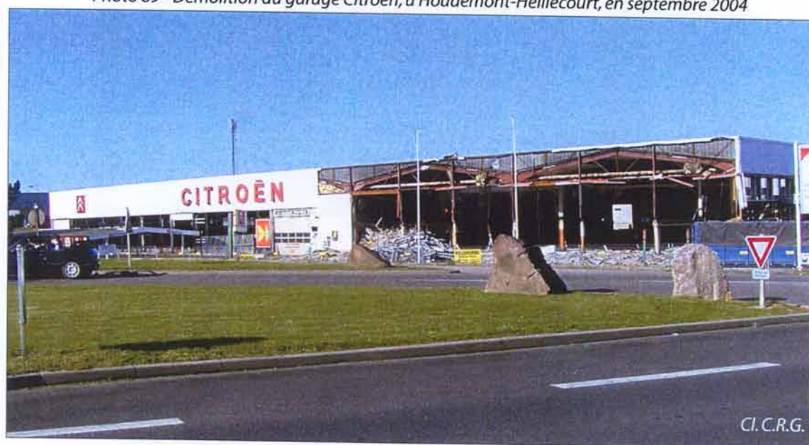
Photo 89 - Démolition du garage Citroën, à Houdemont-Heillecourt, en septembre 2004
