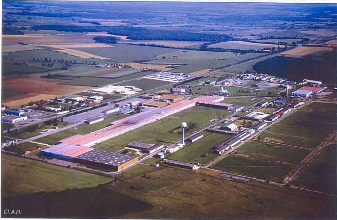
Photo 96 - Les traces de l'ancienne base de l'OTAN dans la ZI de la Croix-de-Metz, à Toul (54, 1993)
