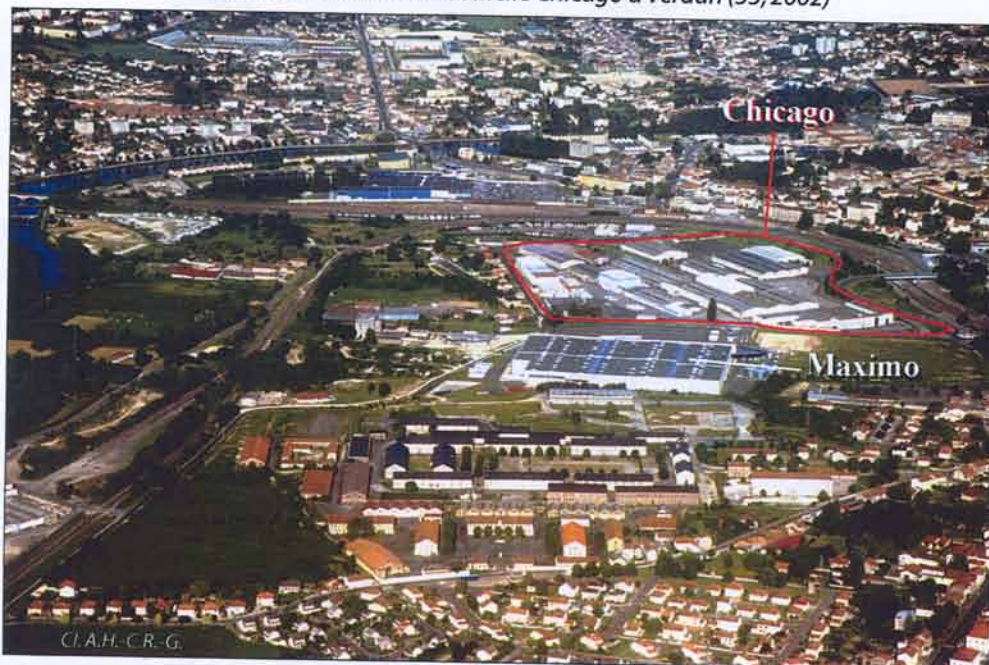
Photo 95 - La zone industrielle Chicago à Verdun (55, 2002)
