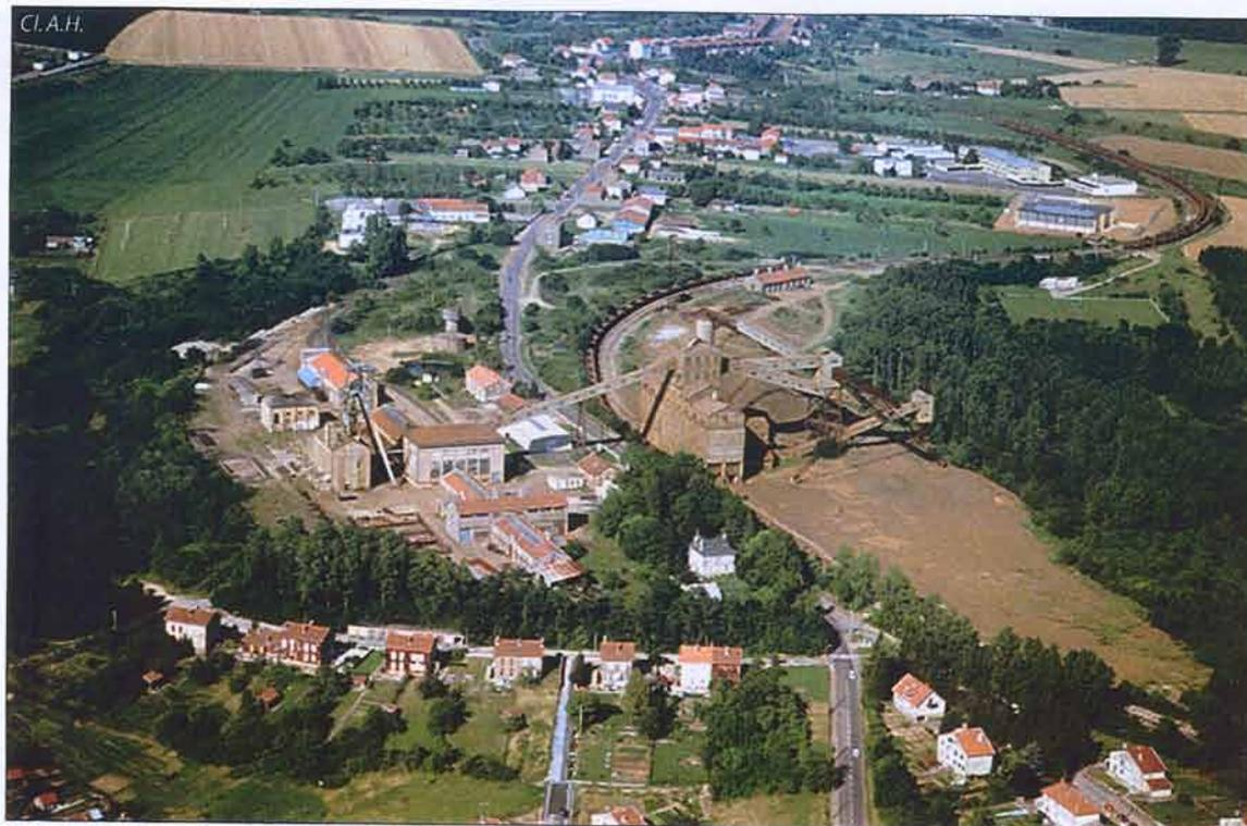
Lors de cette prise de vue en 1990, la mine est encore en activité et alimente par convois ferroviaires les hauts fourneaux encore fonctionnels des vallées de l'Orne et de la Fensch. À droite de la voie ferrée en S s'élève le chevalement à partir duquel un convoyeur alimente les installations de criblage et de lavage du minerai.
