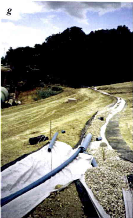
a : CET avant la remédiation (H.p.) ; b : création du bassin des eaux drainées ; c : mise en place de la digue d'étanchéité ; d : mise en place de l'argile (1 m d'épaisseur) ; e : déroulage du géotextile de drainage et du grillage plastique sur lequel est déposé le sol végétal ; f : mise en place du sol végétal (0,4 m) ; g : mise en place des drains ; h : fin de la remédiation ; i : vue générale du CET 1 ½ après remédiation.
