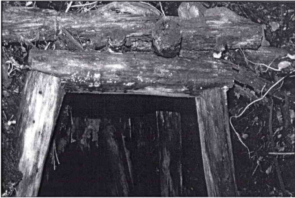
4. Premier cadre (piles et chapeau) et garnissage dans une charbonnière de Villard-Saint-Pancrace (photo J.L.T., 1991)
