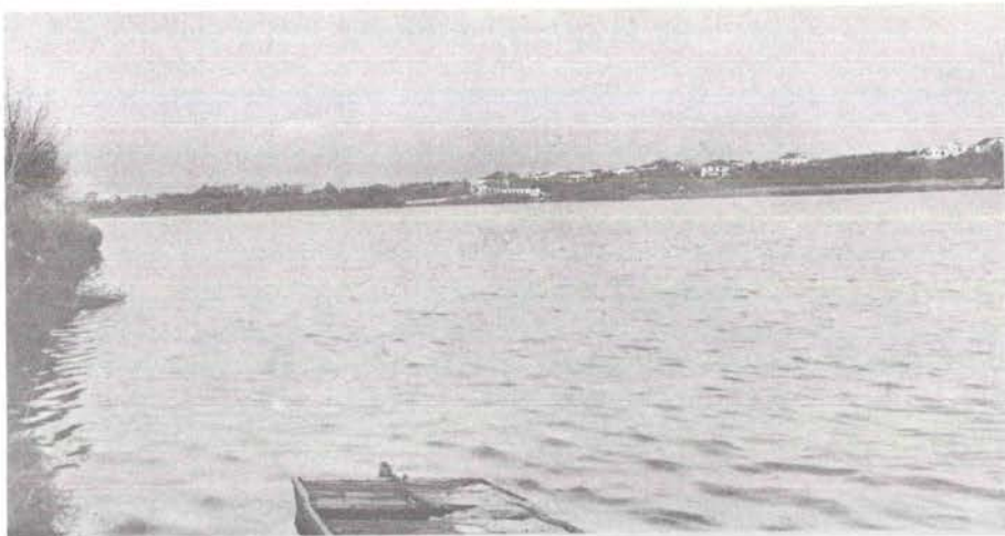
bassin de rétention (72 ha)
