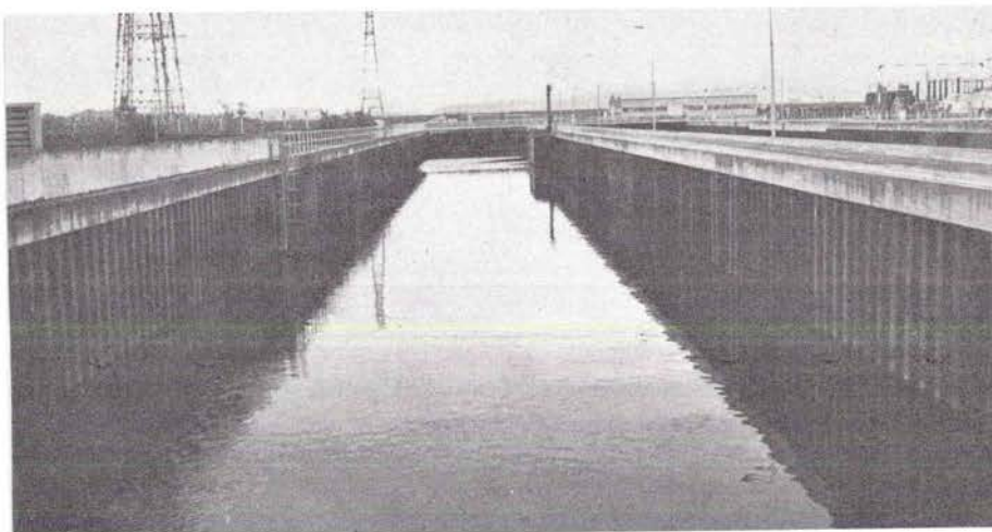
pompage des eaux
