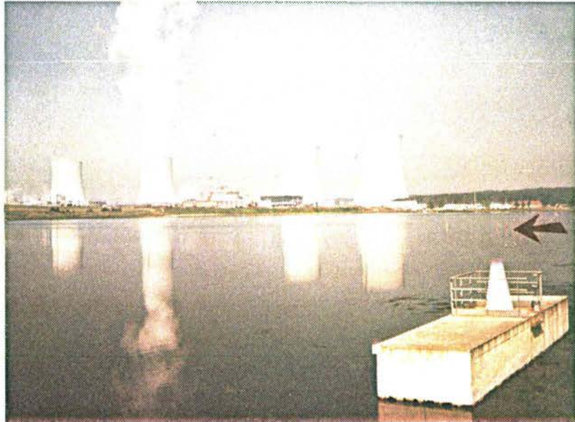
Retenue du Mirgenbach: la centrale vue de la station 2 Unité 1 en marche
