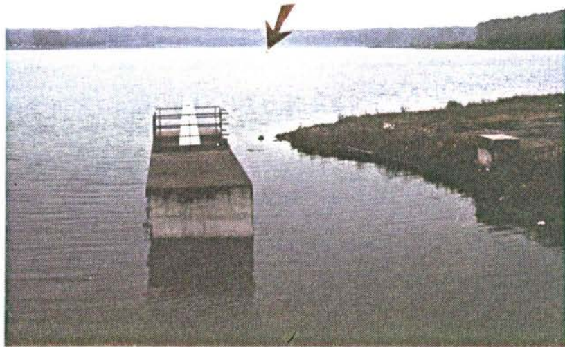
Station 3 située dans la retenue
