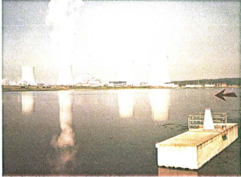
Retenue du Mirgenbach: la centrale vue de la station 2 Unité 1 en marche
