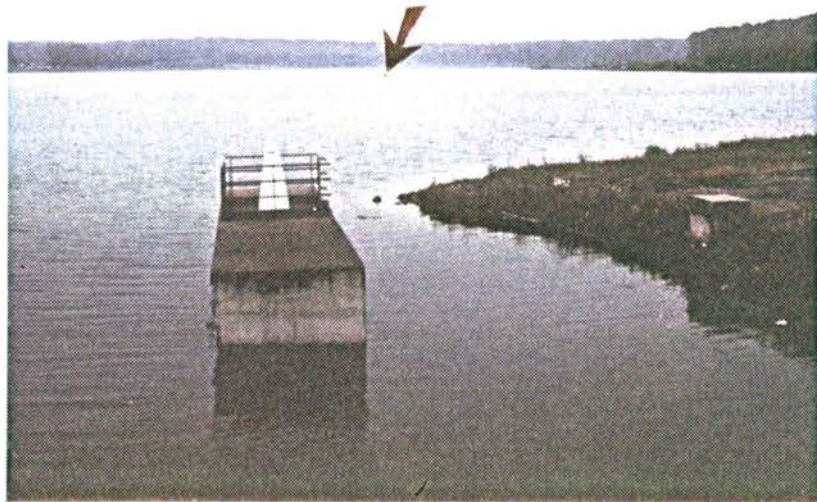
Station 3 située dans la retenue
