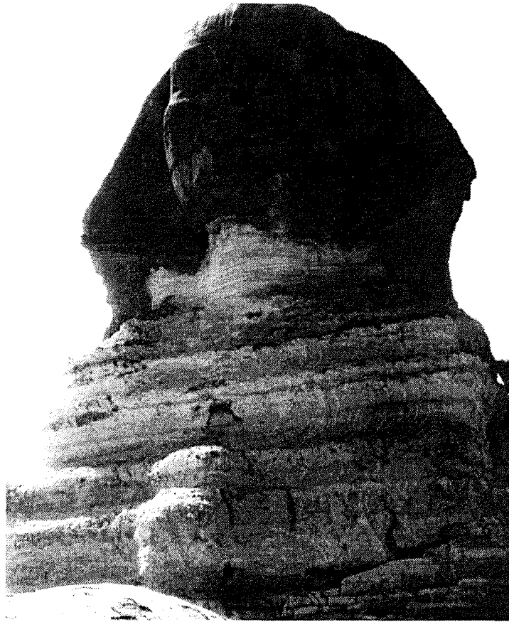
Photo 2-3. Erosion différentielle sur le cou du Sphinx
