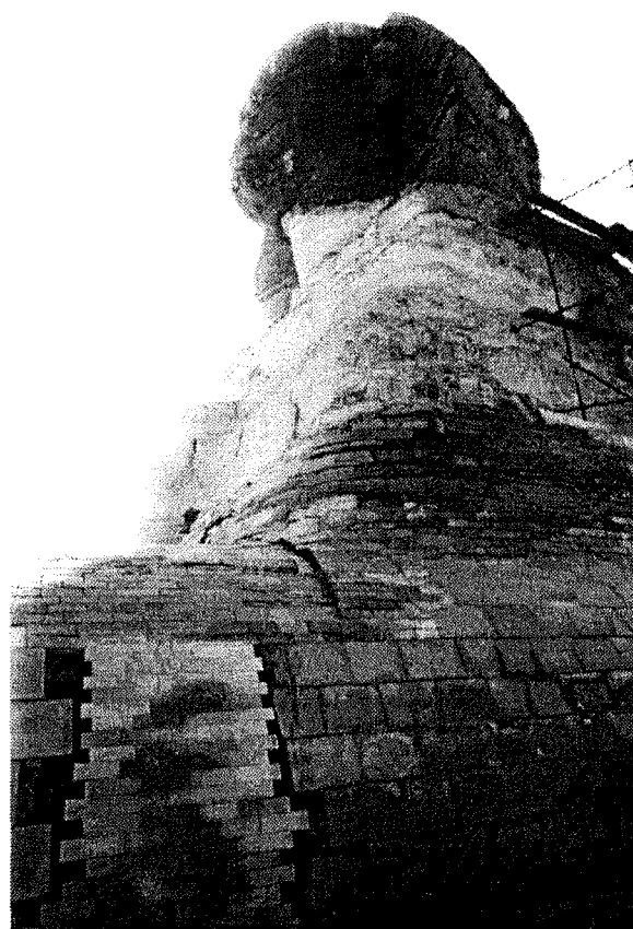
Photo 2-5. : Exemple de restauration inadaptée qu'il est nécessaire de changer (Le Sphinx)
