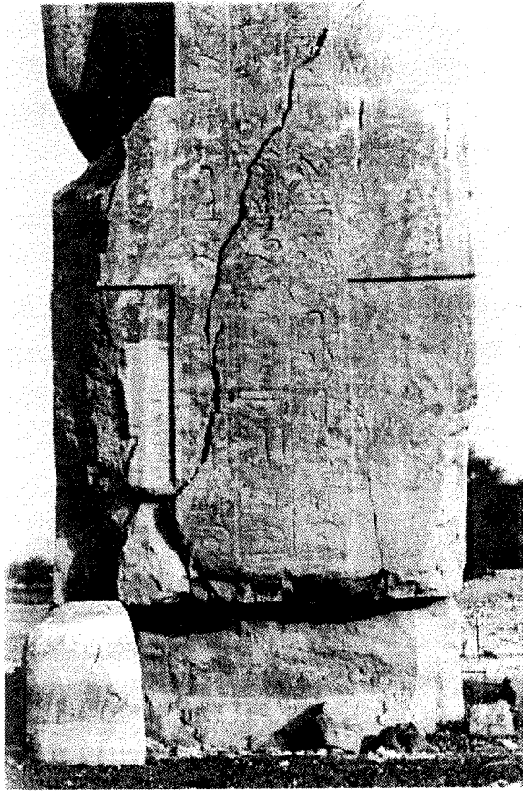
Photo 4-5. Vue arrière du Colosse Sud, traversé d'une fissure oblique et endommagé au niveau du socle
