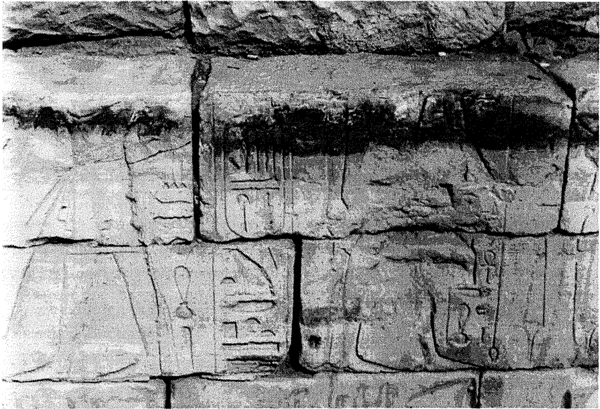
Photo 2-1. Cristallisation des sels sur le temple de Louxor
