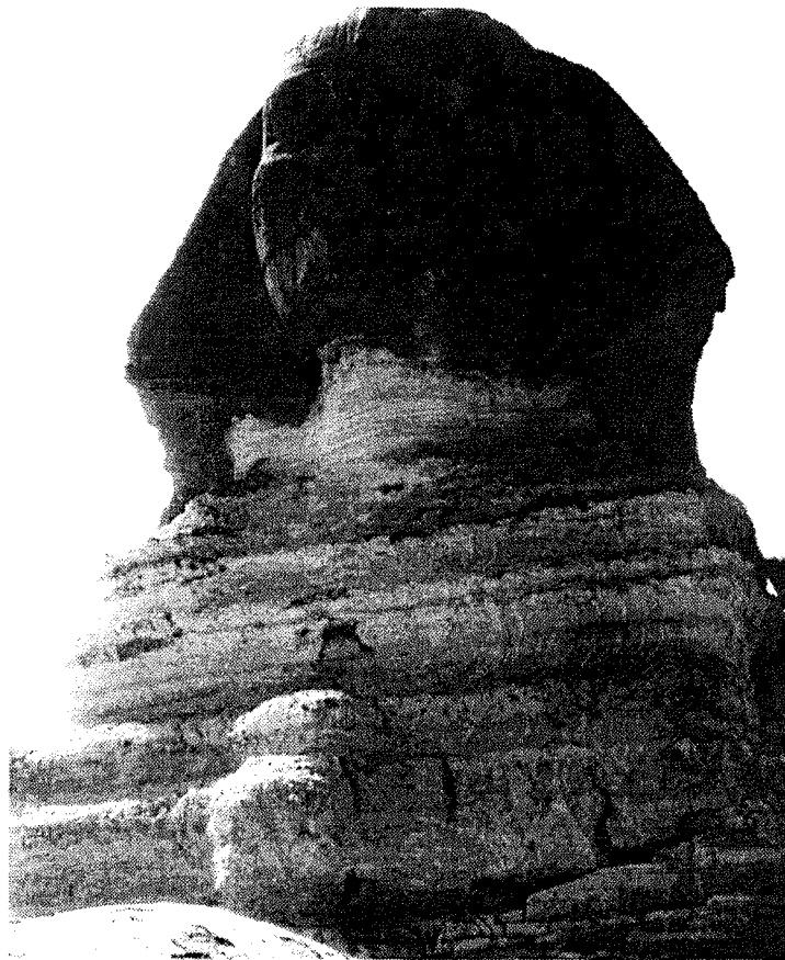
Photo 2-3. Erosion différentielle sur le cou du Sphinx
