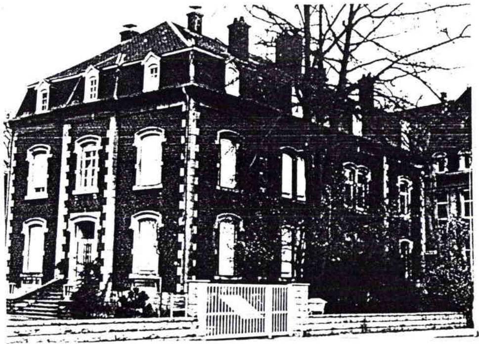
4 DUDELANGE, rue K. Marx ancienne maison d'ingénieur
