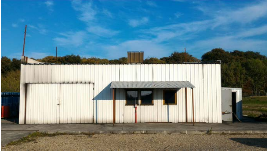
FIGURE 2.1 – Vue extérieure du local d'essais de la première campagne expérimentale.
